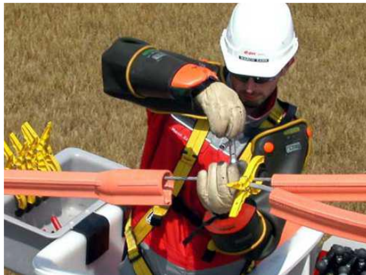
Slika 6: Delo z izolacijskimi rokavicami – delo v dotiku (Vir: Lovrenčič, 2018)
