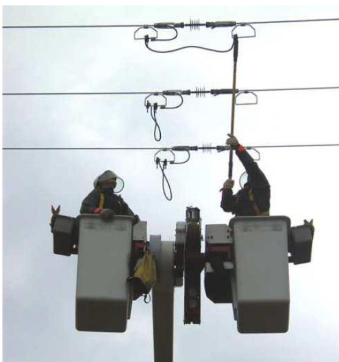
Slika 5: Delo z izolacijskimi palicami (Vir: Lovrenčič, 2018)
