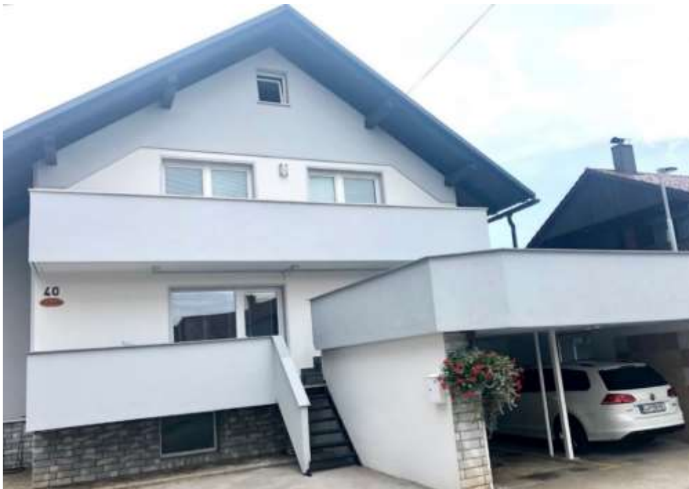
Slika 1: Stanovanjski objekt – Mlakarjeva ulica (Lastni vir)
