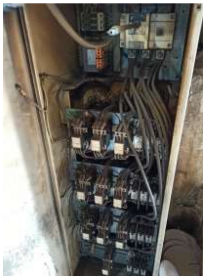
Slika 22: Obstoječa kompenzacijska naprava na območju »Montaža 1« (Lastni vir)
