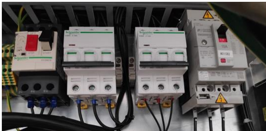
Slika 13: Motorno zaščitno stikalo, varovalke (Lastni vir)
