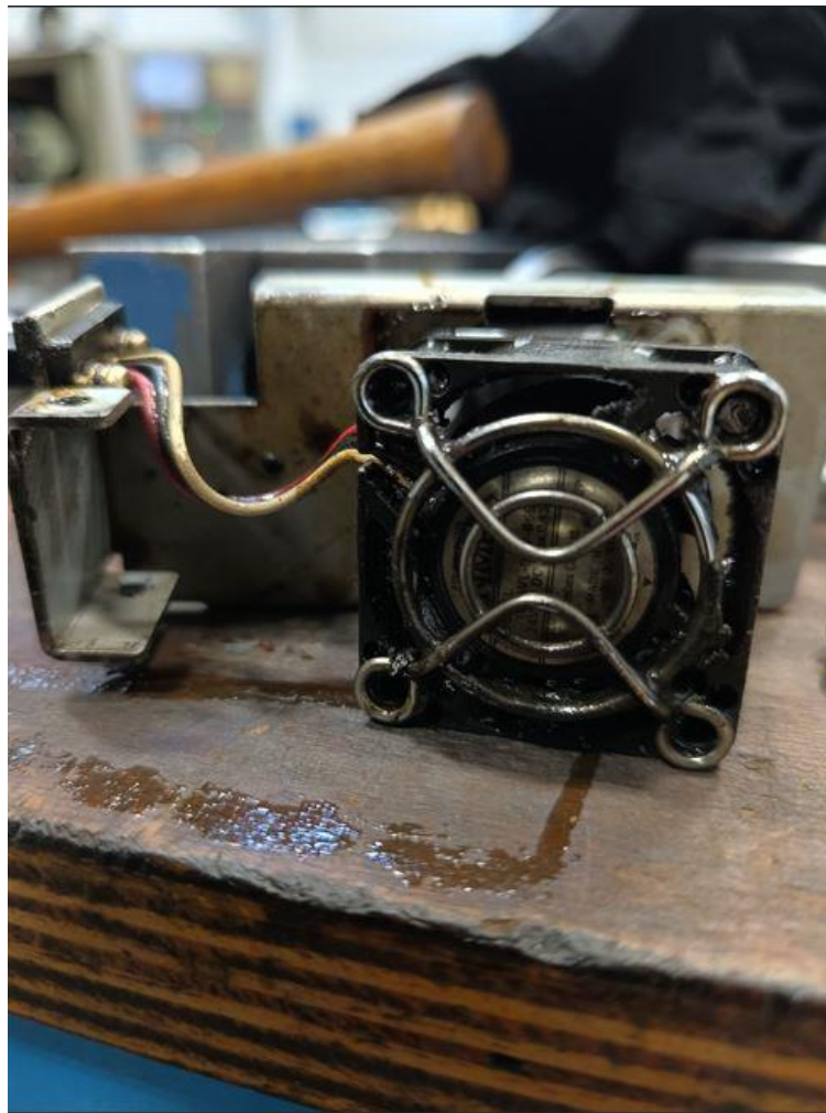
Slika 23: Ventilator, izpostavljen vplivom okolja (Lastni vir)
