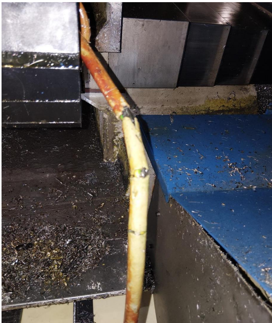
Slika 22: Poškodba kabla (Lastni vir)
