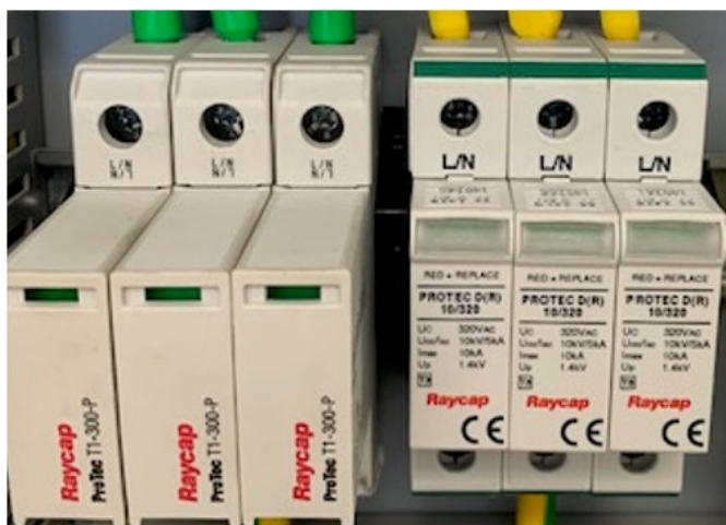
Slika 14: Odvodniki prenapetosti (Lastni vir)
