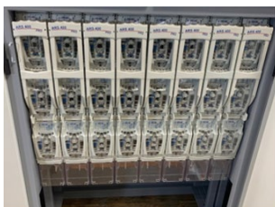
Slika 12: NV (NH) varovalčno ločilno stikalo (Lastni vir)
