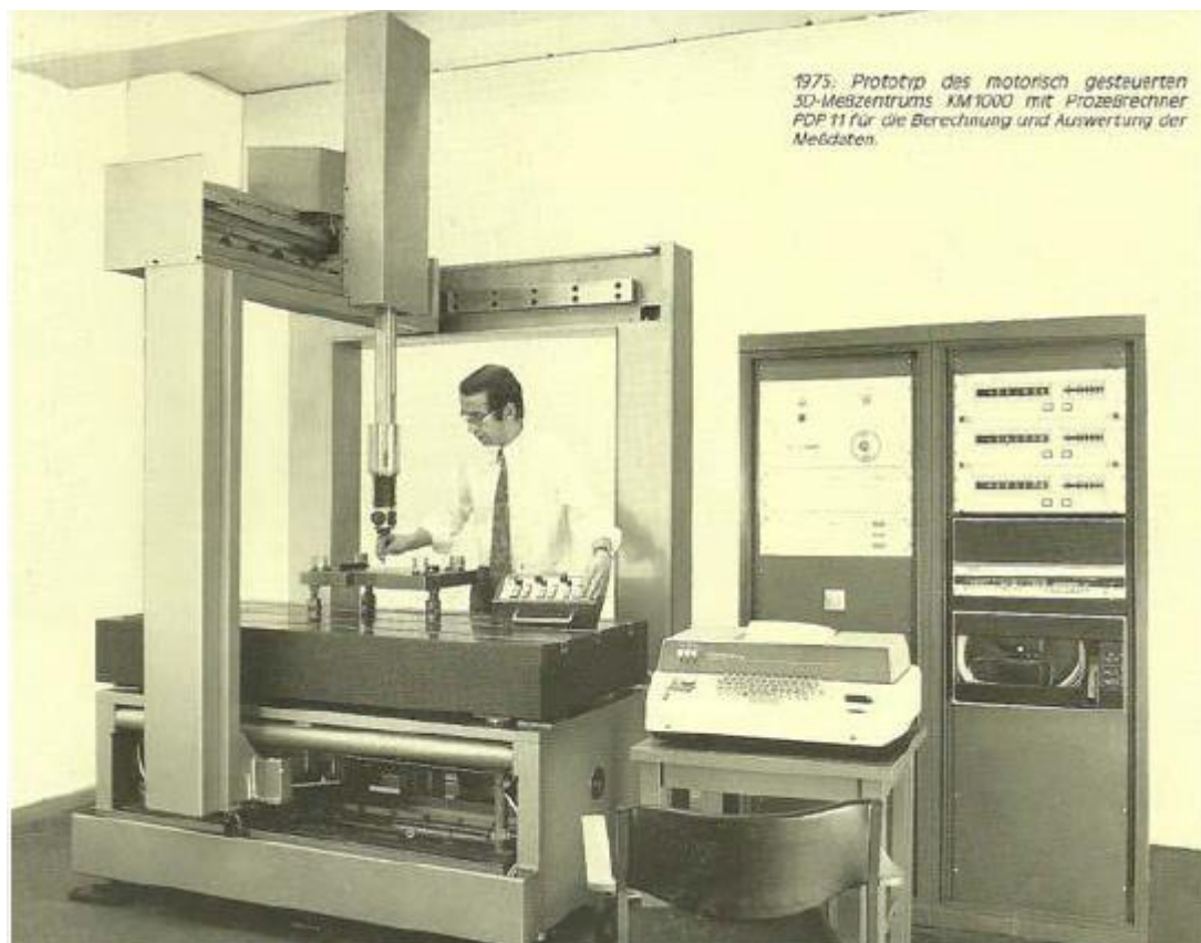
Slika 5: Prvi KMS z integriranim računalnikom (Vir: Žiljcov, 2010)
