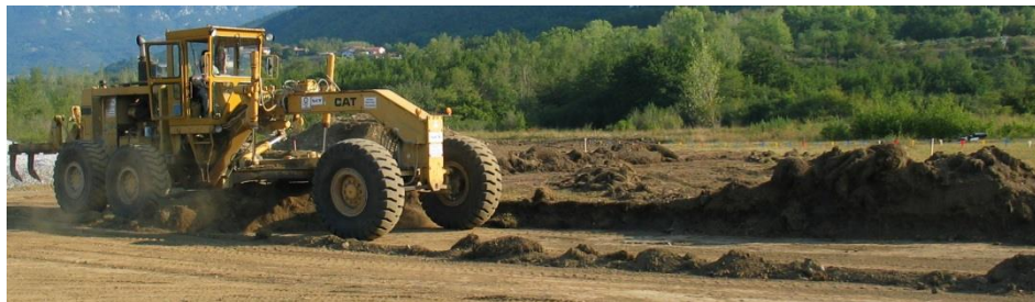
Slika 12: Odriv humusa z grederjem CAT G12 (Vir: Interno gradivo SCT, 2005)
