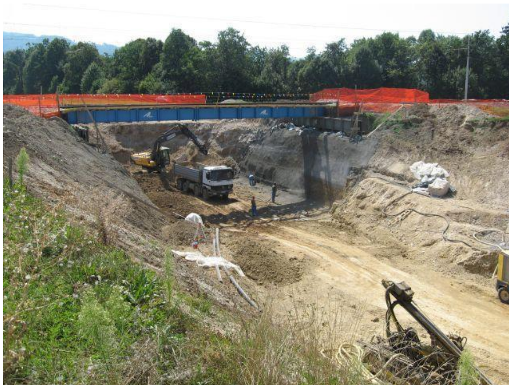
Slika 8: Primer gradnje cest (Vir: Interno gradivo SCT, 2010)
