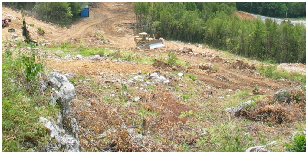
Slika 16: Pogled z vrha vkopa Polance na glavno cesto G1/12. (Vir: Interno gradivo SCT, 2005)
