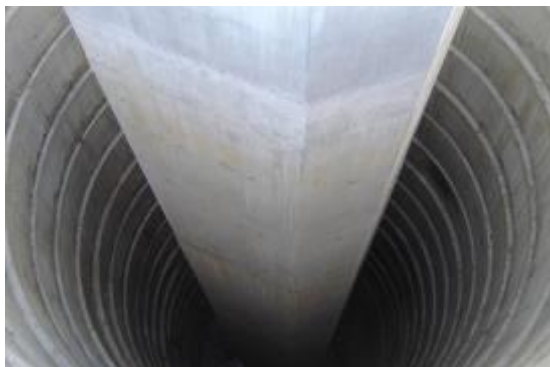
Slika 1: Primer izkopa vodnjaka za steber viadukta (Vir: Interno gradivo SCT, 2010)
