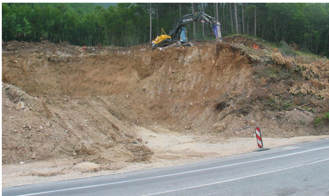
Slika 14: Začetek zemeljskih del na gradbišču (Vir: Interno gradivo SCT, 2005)
