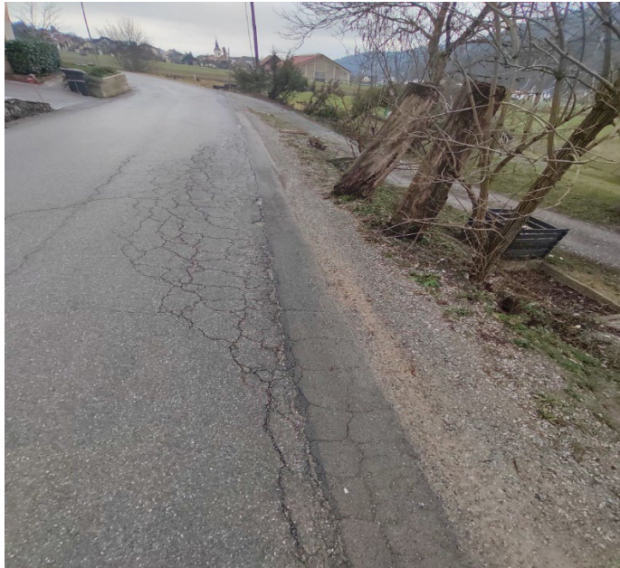
Slika 15: Prikaz posedanja cestišča Zalarjeve ceste (Lastni vir)
