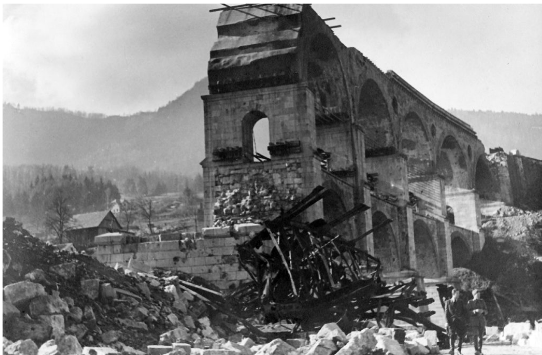
Slika 9: Podrta Roth – Waagnerjeva premostitve (Vir: Borovniški viadukt, 2020)
