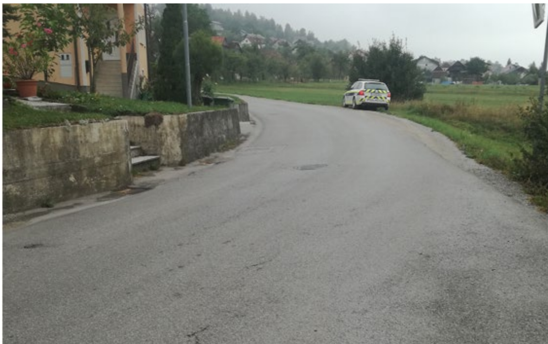
Slika 3: Nevarni odsek Zalarjeve ceste (Vir: Prometno varnostni načrt, 2021)
