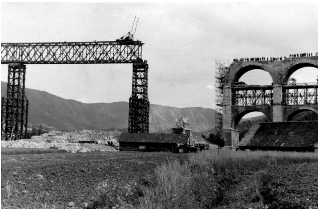
Slika 8: Gradnja Roth – Waagnerjeve premostitve, maj 1941 (Vir: Borovniški viadukt, 2020)
