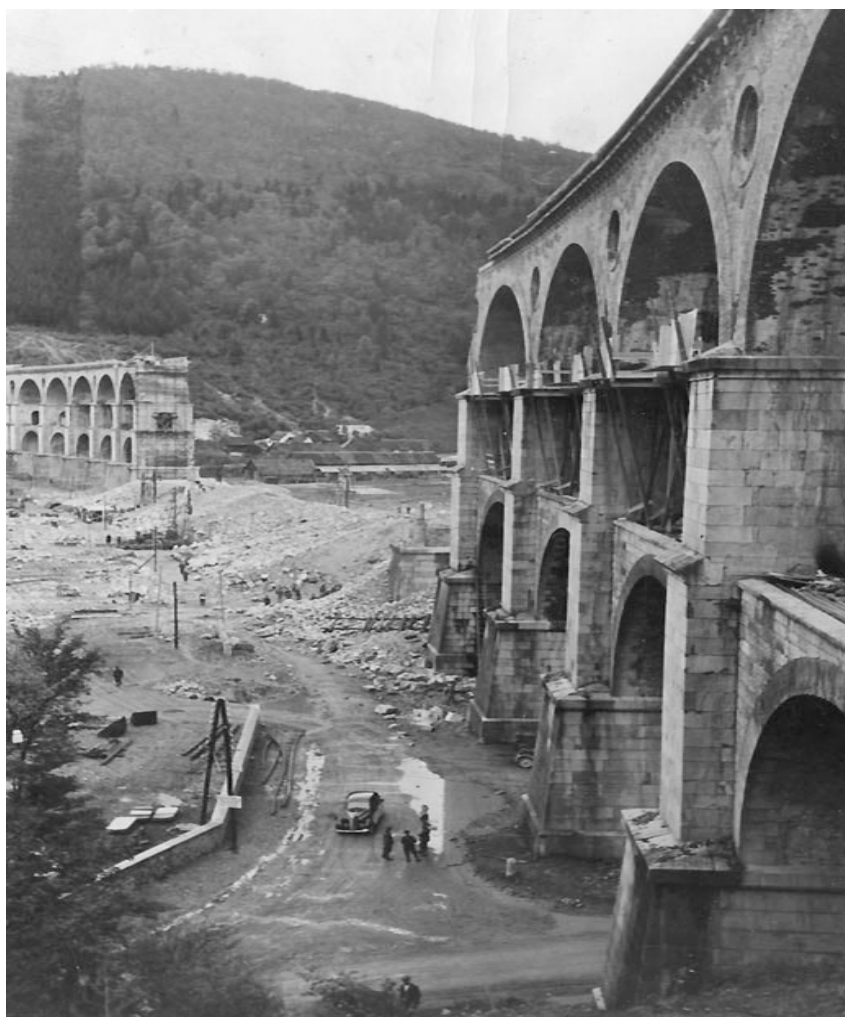
Slika 7: Borovniški viadukt, april 1941 (Vir: Borovniški viadukt, 2020)
