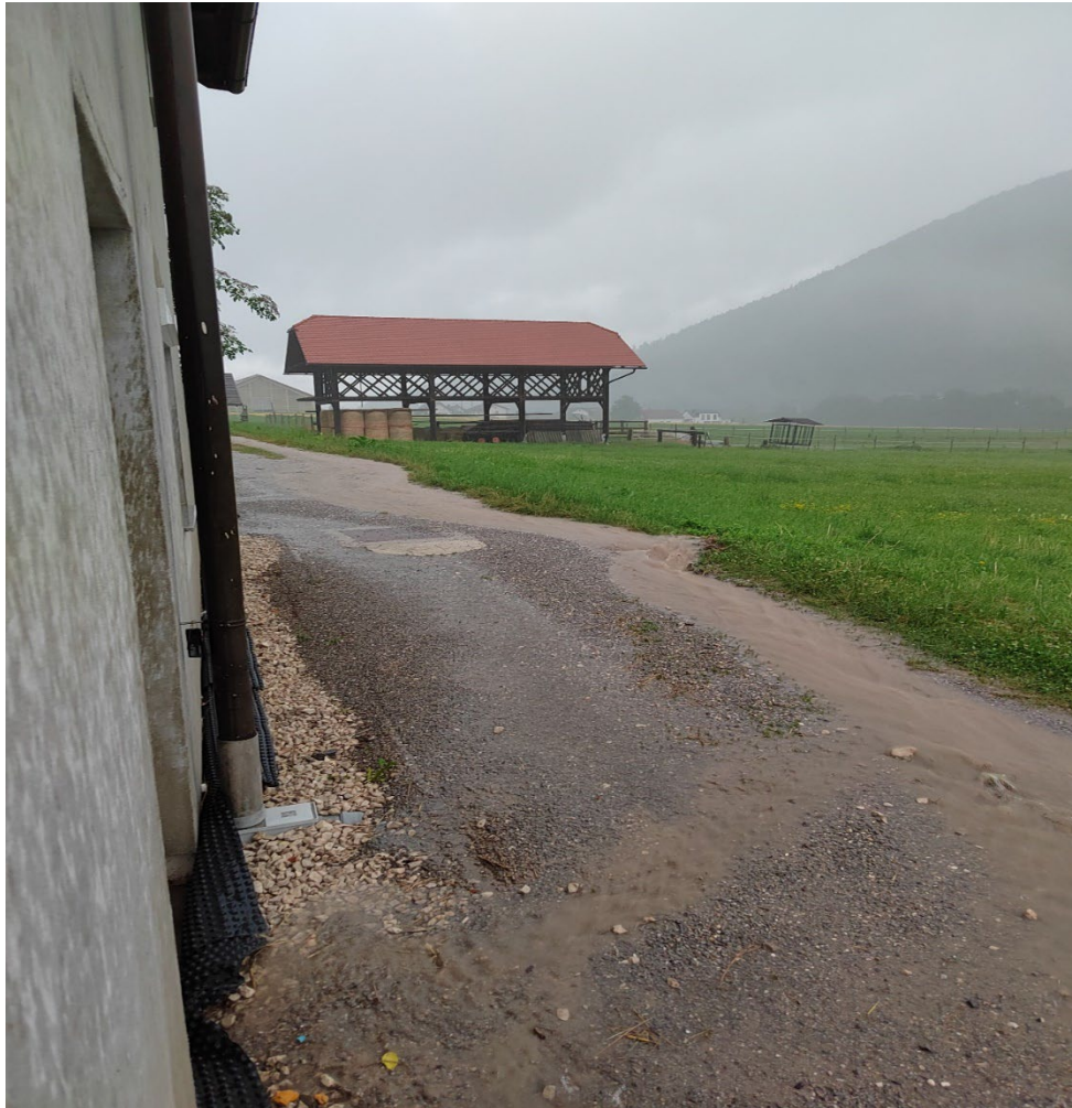
Slika 19: Poplavljen vhod objekta (Lastni vir)
