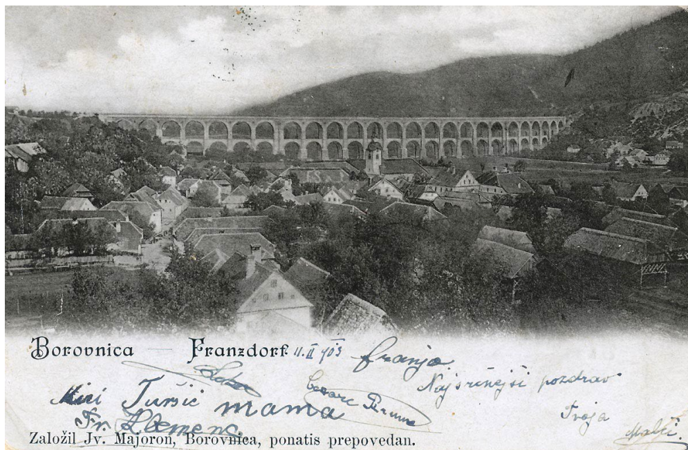
Slika 5: Borovnica Franzdorf (Vir: Borovniški viadukt, 2020)
