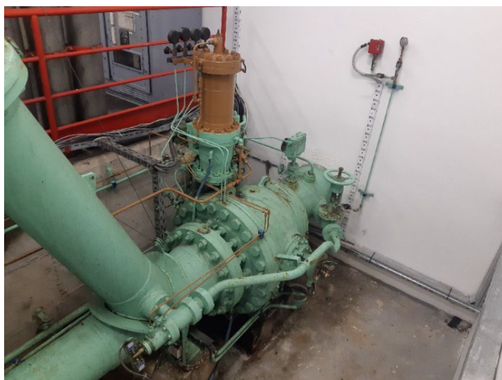
Slika 3: Predturbinski zaporni organ (Lastni vir)
