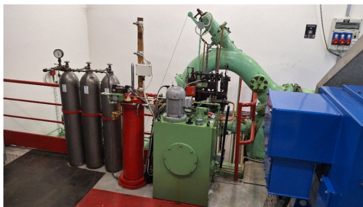
Slika 4: Hidravlično upravljalni del turbinskega regulatorja (Lastni vir)
