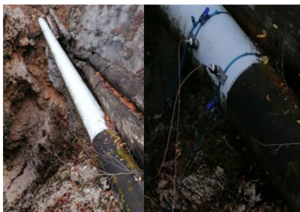
Slika 8: Postavitev merilnika pretoka na cevovod (Lastni vir)
