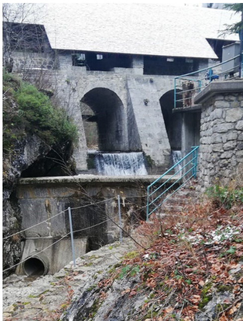
Slika 15: Zajem vode za mHE Mrzla Rupa tik pod klavžami (Lastni vir)
