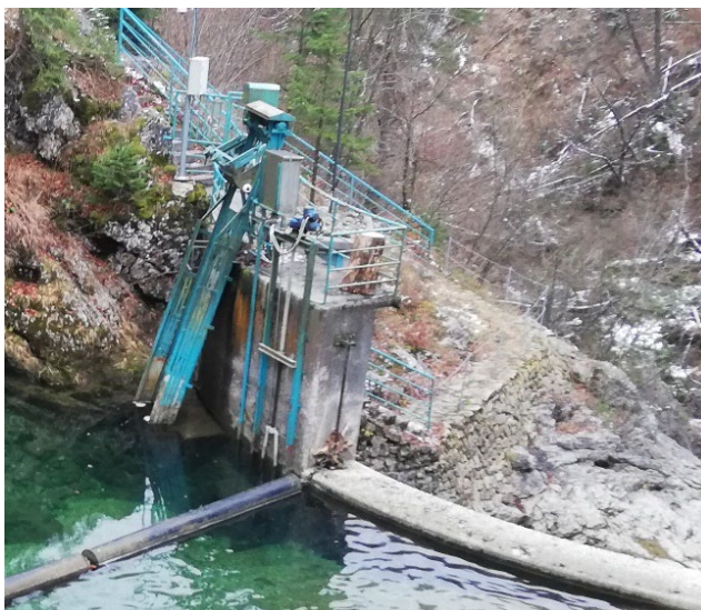
Slika 5: Čistilni stroj na vtoku (Lastni vir)
