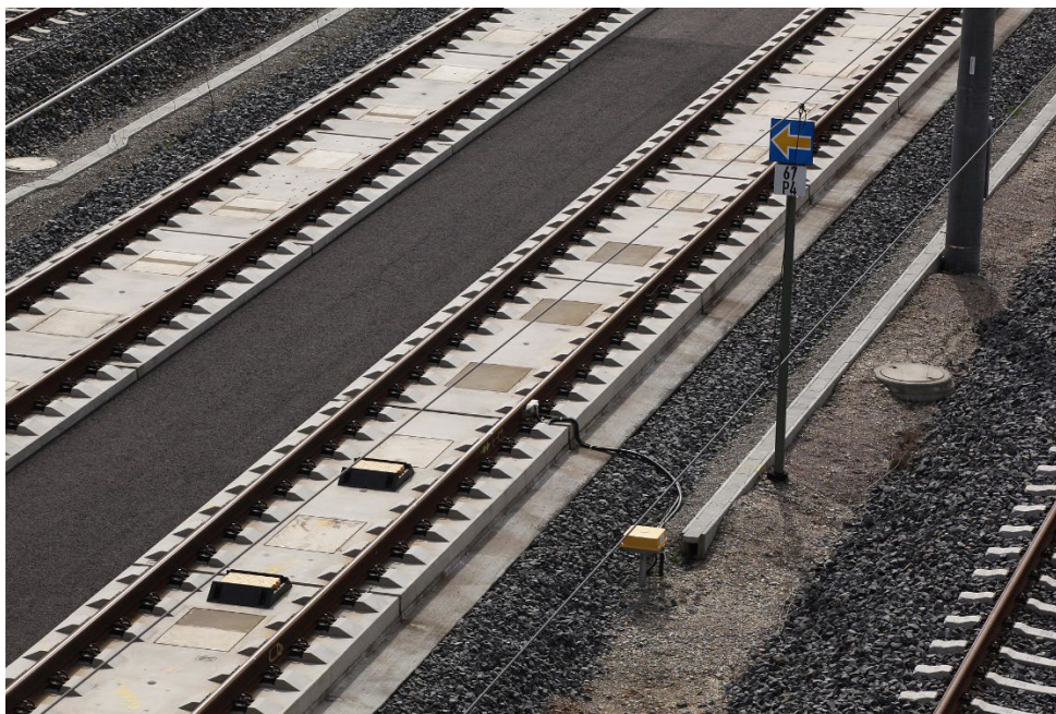
Slika 3: ETCS-Stop Marker z balizno skupino in števcem osi (Vir: Störfix, 2016)
