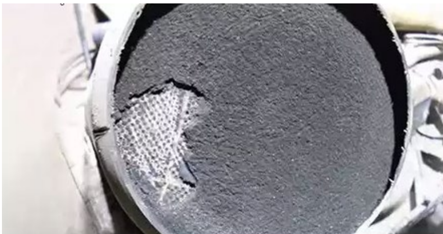
Slika 41: Zamašen filter DPF (Vir: Dpfaustralia portal, 2019) 29
