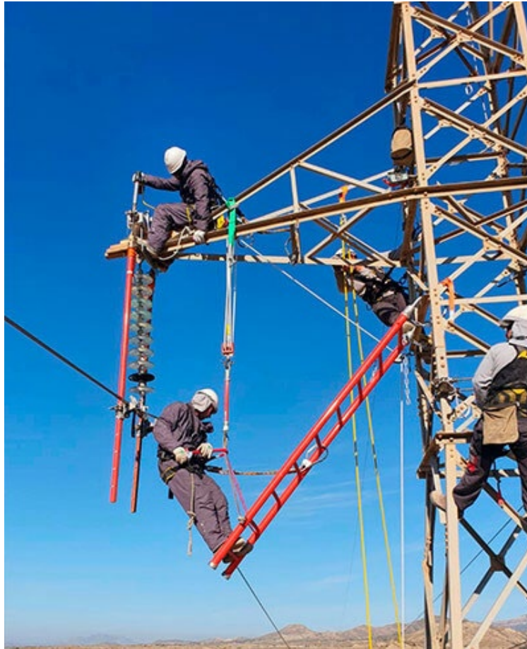
Slika 9: DPN na potencialu z izolacijskimi lestvami (Vir: Kolabensayos, 2021)
