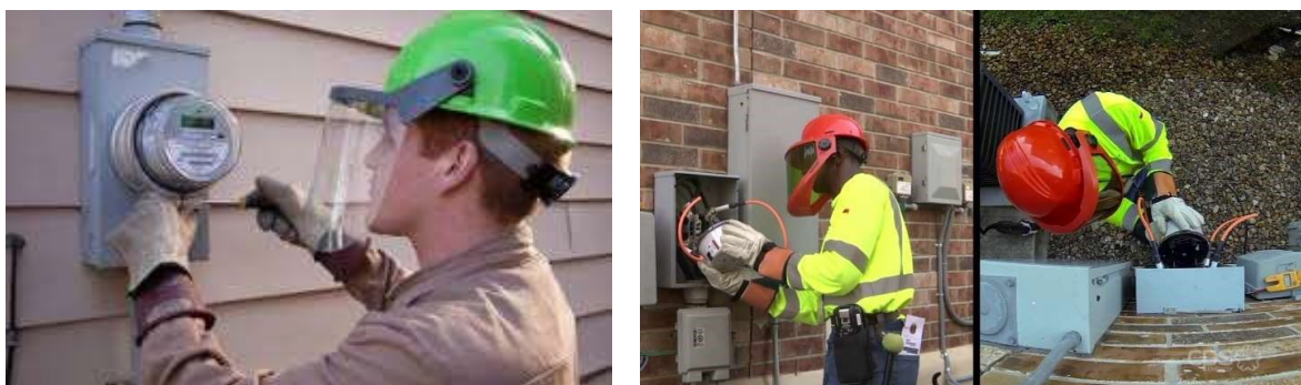
Slika 11: Elektromonter med opravljanjem DPN z uporabo primerne OVO (Vir: Lovrenčič, 2020)
