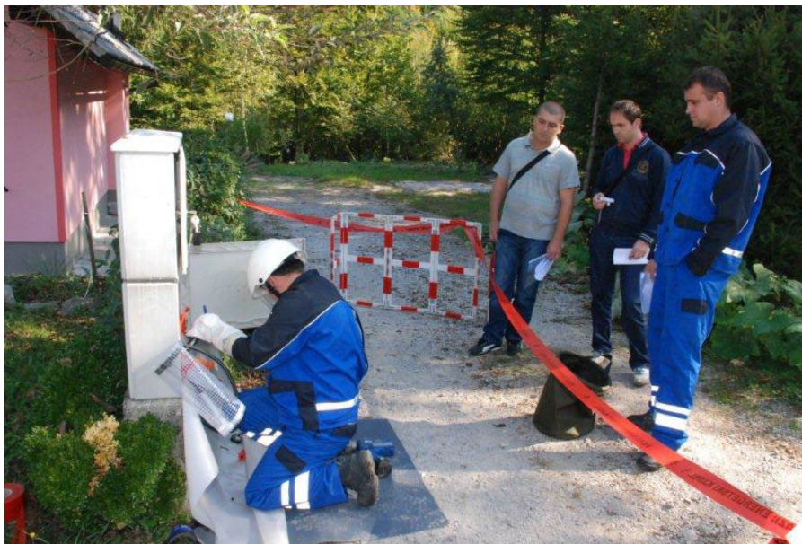
Slika 3: DPN pod strokovnim nadzorom (Vir: Elektro Ljubljana, 2011)
