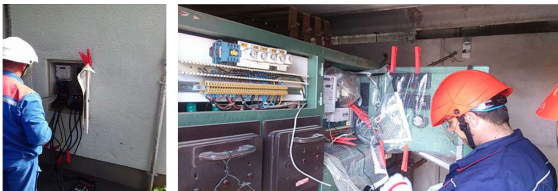
Slika 12: Praktična uporaba OVO in delovne opreme za DPN (Vir: Lovrenčič, 2020)
