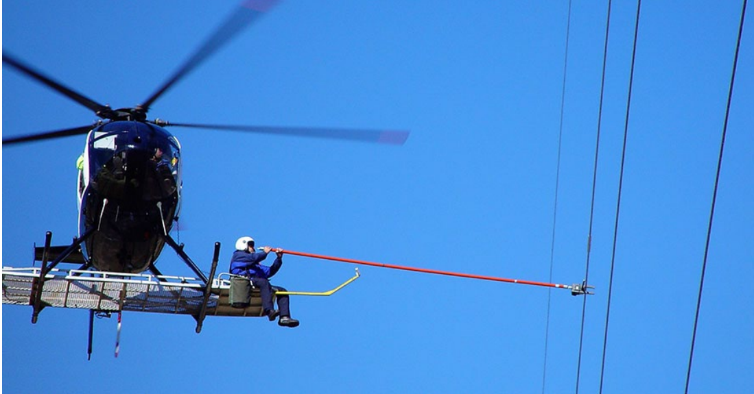
Slika 4: DPN na VN daljnovodu (Vir: Aeropower, 2024)
