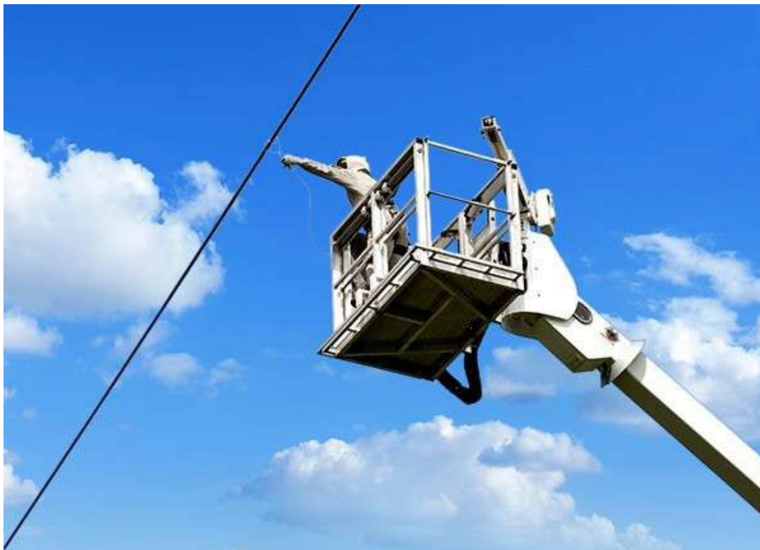
Slika 7: Delo na potencialu z dvižne avtokošare v Italiji (Vir: Carrarotecnico, 2024)
