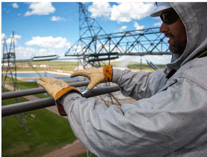
Slika 8: Monter v Faradayevem kombinezonu med DPN na 345 kV daljnovodu (Vir: Magstadt, 2024)
