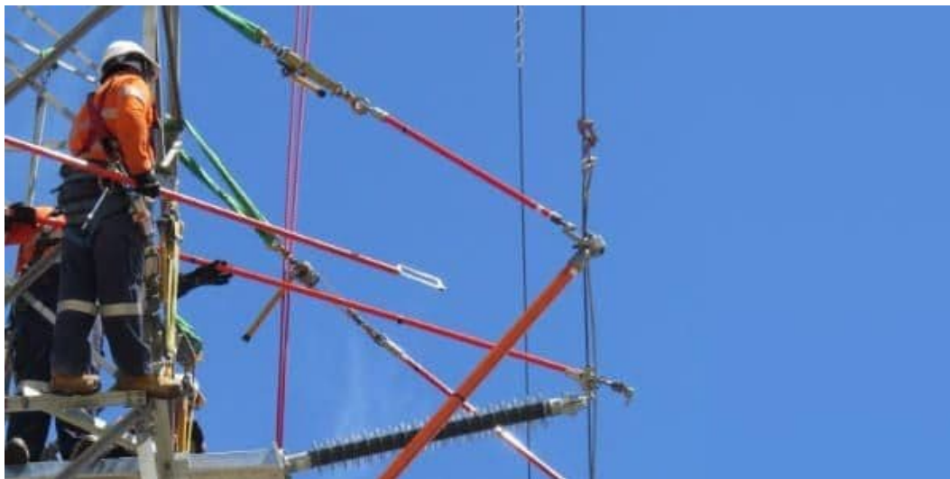
Slika 5: Delo na oddaljenosti v Avstraliji (Vir: Powerline Training, 2017)
