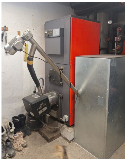
Slika 20: Trenutni vir ogrevanja – predelana peč na pelete (Lastni vir)
