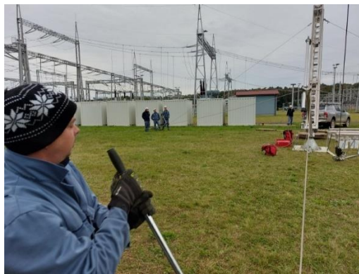
Slika 38: Uporabljen tirfor, namesto vitla (Lastni vir)
