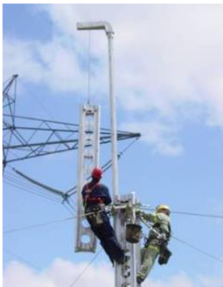
Slika 31: Montaža modula na vrh stebra (Vir: ELES, d. o. o., 2022)
