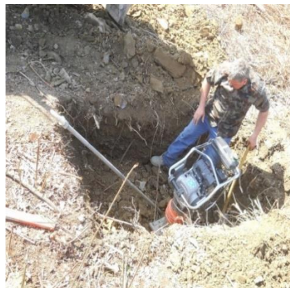
Slika 17: Teptanje podlage nad sidrom (Lastni vir)
