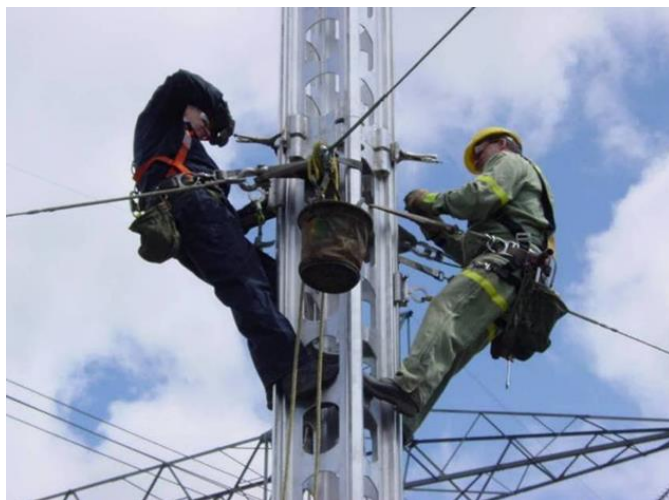
Slika 32: Pritrjevanje modula stebra s prilagoditvenimi kleščami in namestitve vijakov
