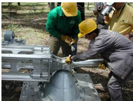
Slika 34: Namestitev montažnega droga na zglobno osnovo (Vir: ELES, d. o. o., 2022)
