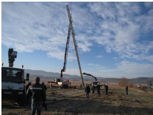
Slika 40: Dvig z avtodvigalom na DV 110kV Ajdovščina – Nova Gorica. (Vir: ELES, d. o. o., 2022)
