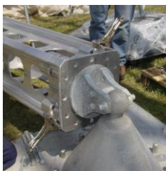
Slika 33: Namestitev modula na zglobno osnovo (Vir: ELES, d. o. o., 2022)
