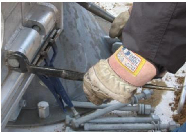
Slika 25: Privijanja modula k osnovnemu bloku (Vir: ELES, d. o. o., 2022)
