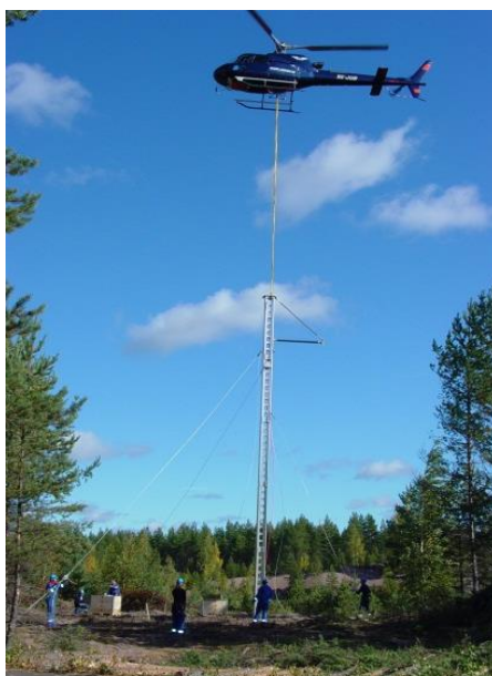
Slika 41: Postavitev s helikopterjem. (Vir: ELES, d. o. o., 2022)
