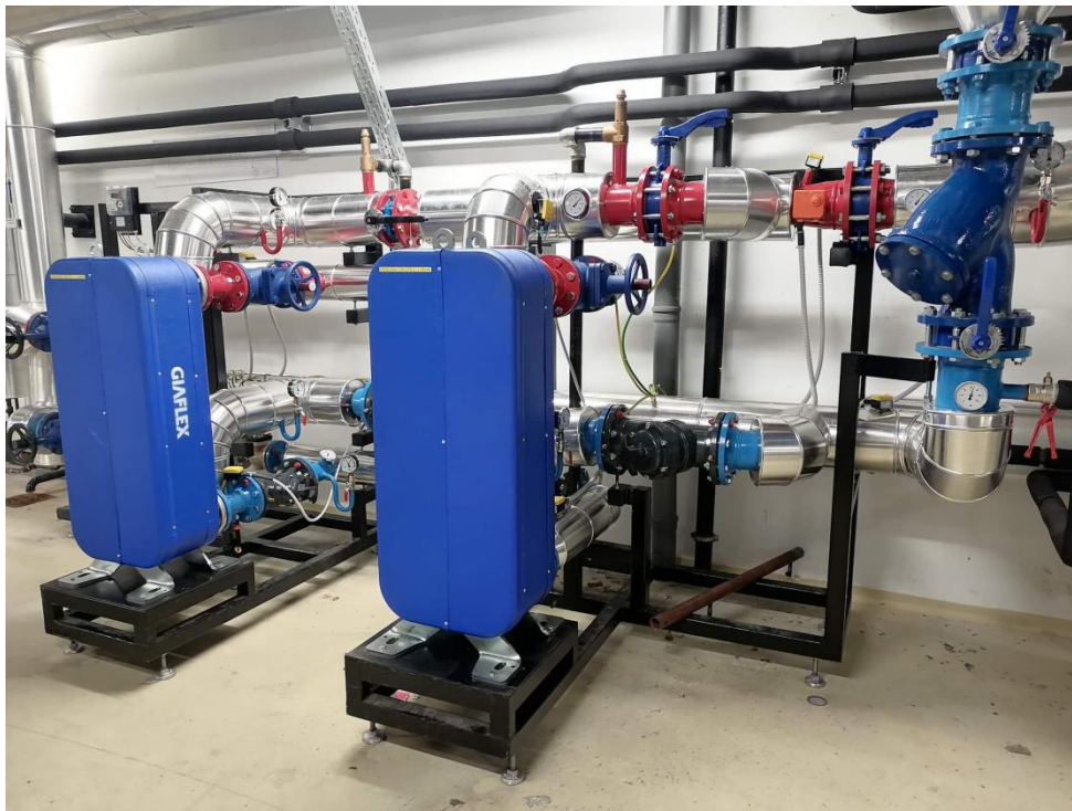
Slika 3: Prenos toplote s primarnega na sekundarni medij (Lastni vir)
