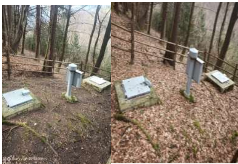
Slika 13: Očiščena in zagrajena okolica okoli vodovodnega objekta (Lastni vir)
