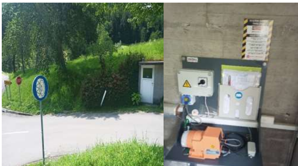
Slika 8: Klorirna postaja ter dozirni sistem Valter DNH (Lastni vir)
