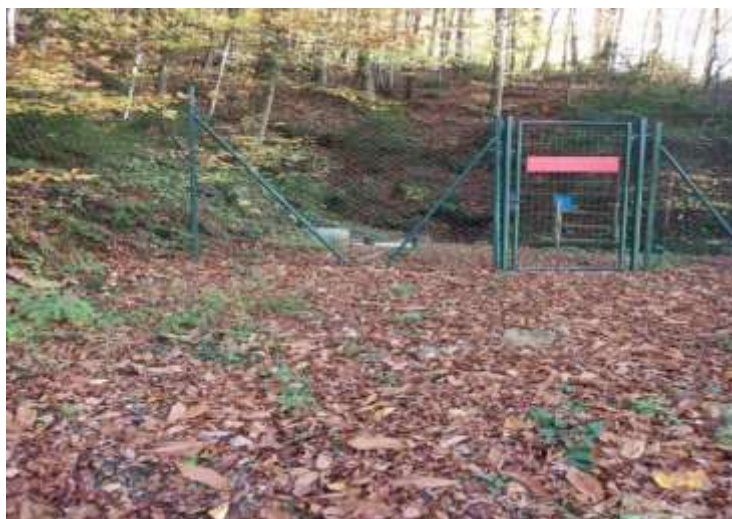
Slika 1: Ograjen vodovarstveni objekt na hribovitem predelu v občini Kamnik (Vir: Avtorjev material, 2023)
