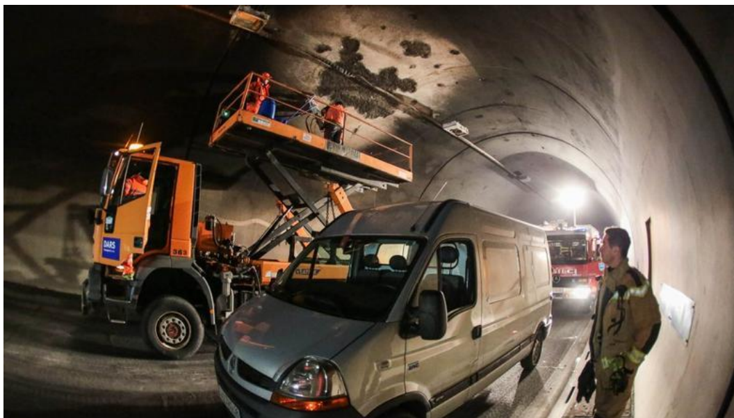
Slika 26: Čiščenje predorov (Lastni vir)
