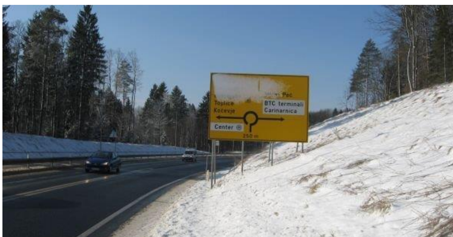
Slika 29: Zasnežena vertikalna signalizacija
