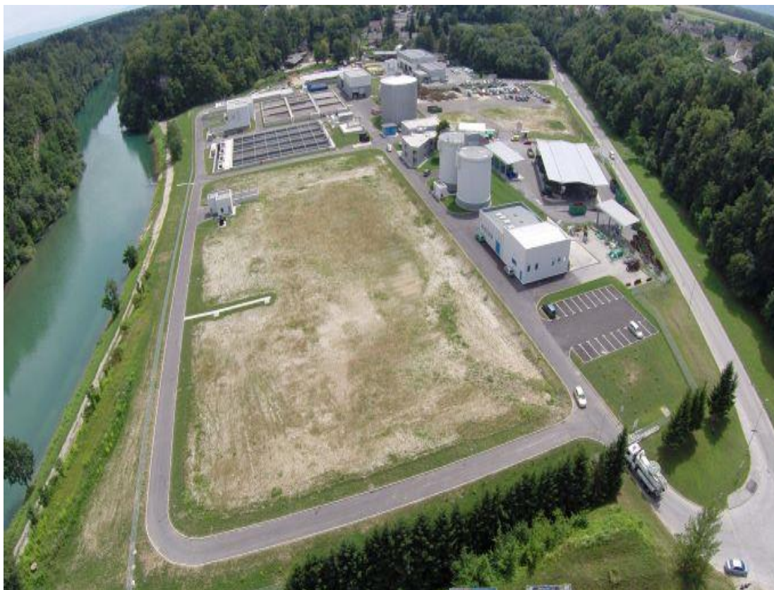
Slika 5: Centralna čistilna naprava Kranj (Vir: Komunala Kranj, 2021)
