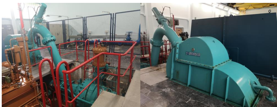
Slika 5: Kroglasti zasun s turbino (Vir: lasten)
