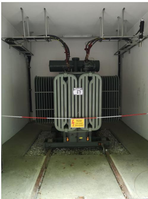
Slika 9: Blok transformator (Vir: lasten)
