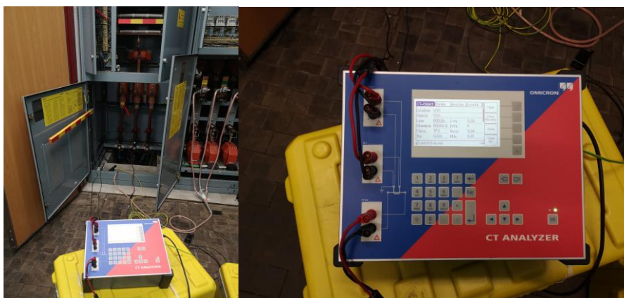
Slika 24: Primarni preizkusi s CT Analyzerjem (Vir: lasten)
