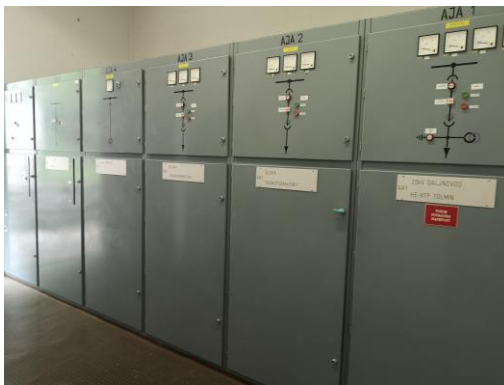
Slika 10: 20 kV celice (Vir: lasten)
