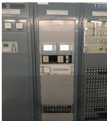
Obnovljena omara zaščite 1CHA (Vir: lasten)
