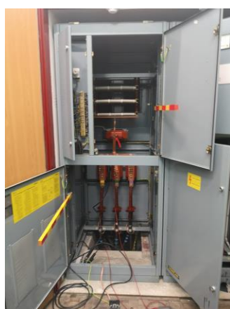
Slika 23: Zvezdišče generatorja (Vir: lasten)
