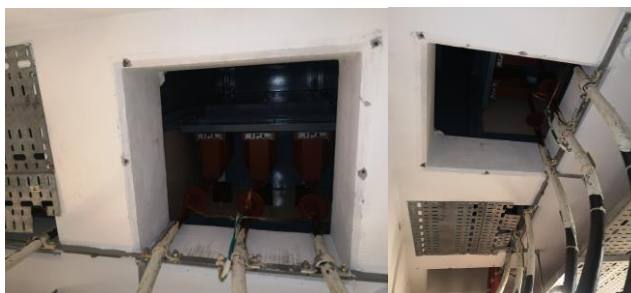
Slika 21: TIT na odvodu 20 kV (Vir: lasten)
