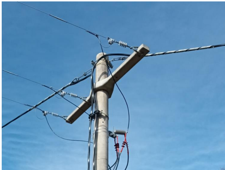
Slika 19: Oporišče 21 (montirane zatezne spirale na univerzalnem kablu) (Lastni vir)
