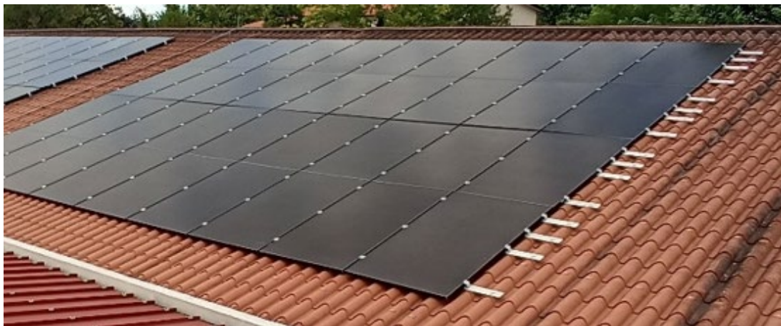
Slika 10: Montirani PV moduli na strehi (Lastni vir)
