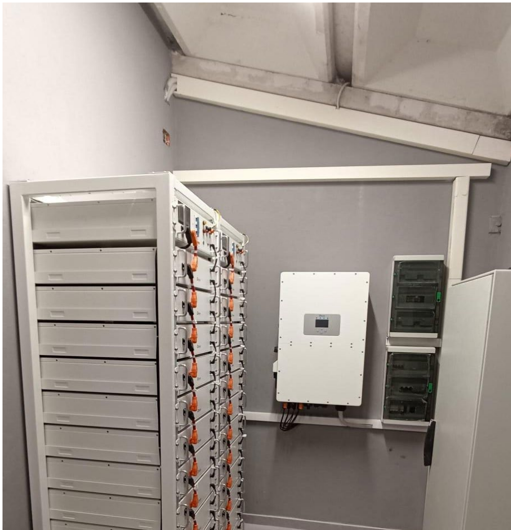
Slika 11: Deye sistem z AC/DC zaščitami (Lastni vir)
