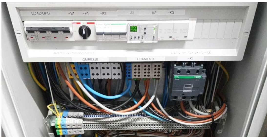
Slika 12: Fizična vezava U-F releja (Lastni vir)
