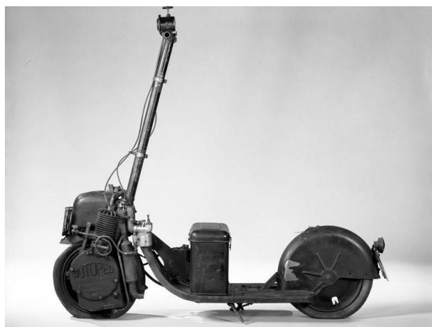
Slika 2: Prvi skiro na motorni pogon – Autoped (Vir: Smithsonian, 2019)
