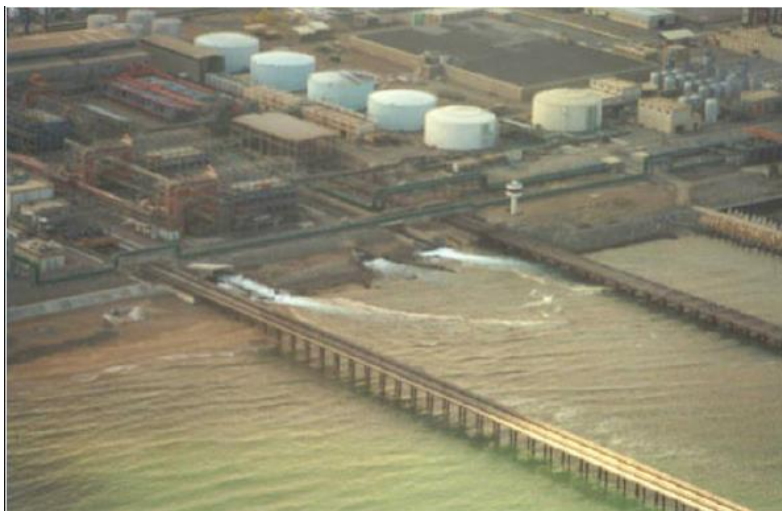
Slika 13: Obrat za razsoljevanje Al Ghubrah (največja v Omanu) s površinskim izpustom (Vir: researchgate.net, 2012)
