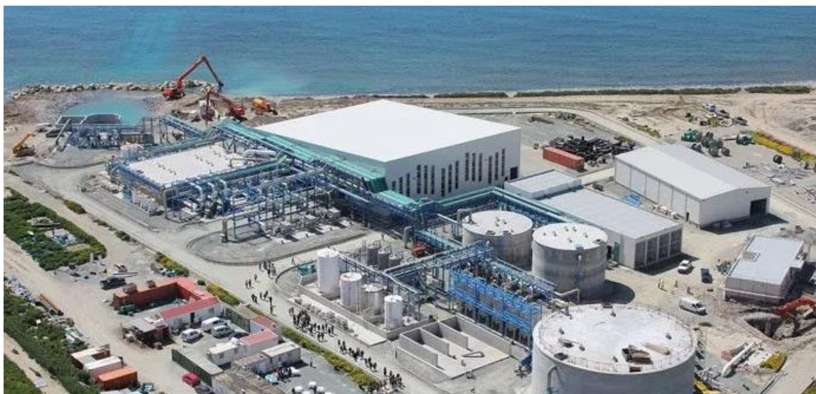
Slika 15: Gradnja objekta za razsoljevanje vode v Libiji (Vir: constructionreviewonline.com, 2016)
