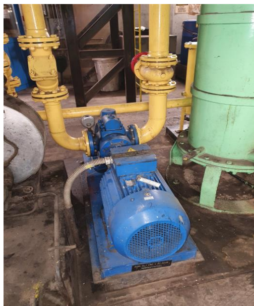
Slika 8: Pomožna oljna črpalka 22 kW (Lastni vir)
