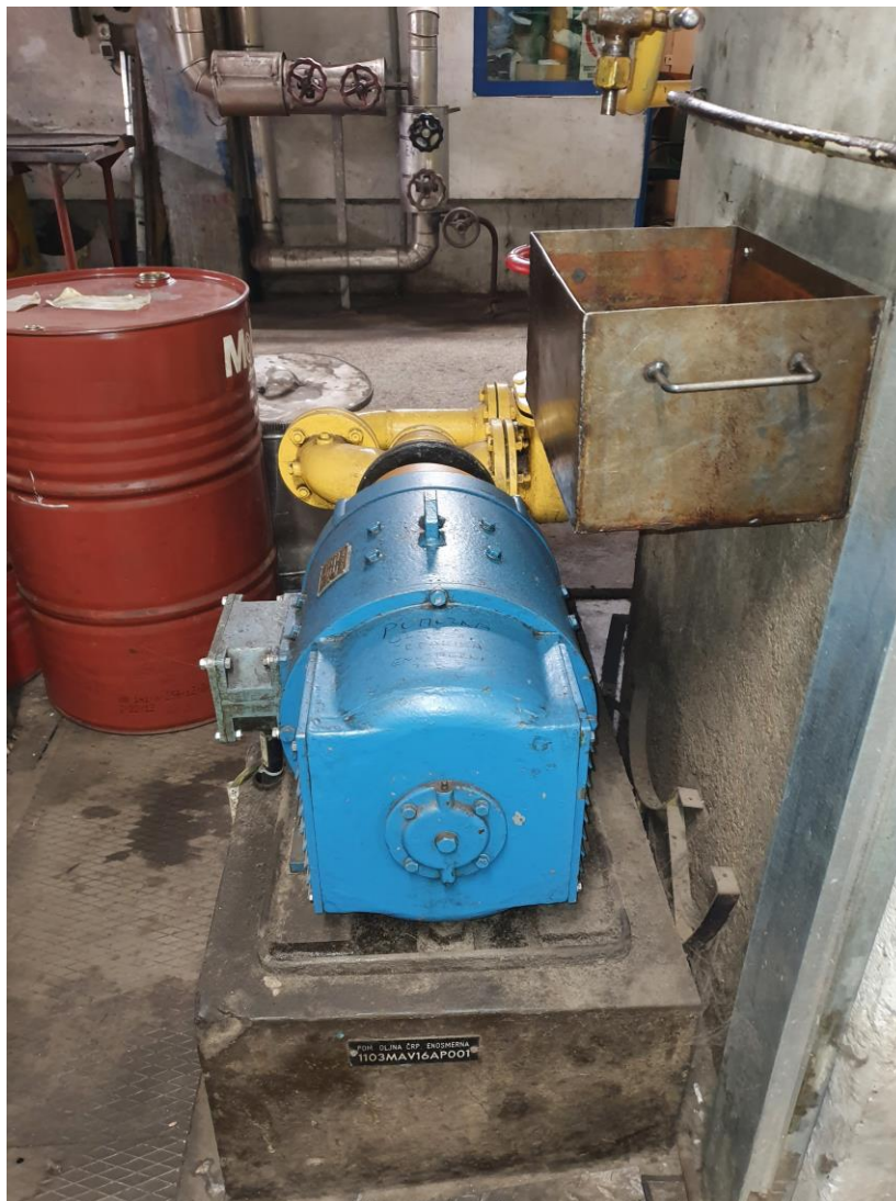
Slika 10: Pomožna oljna črpalka na enosmerni tok (Lastni vir)
