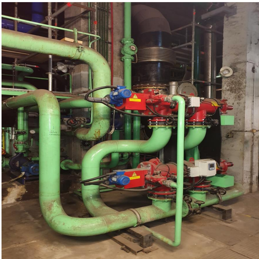
Slika 14: Fini filter Amiad SAF za fino filtriranje hladilne vode (Lastni vir)
