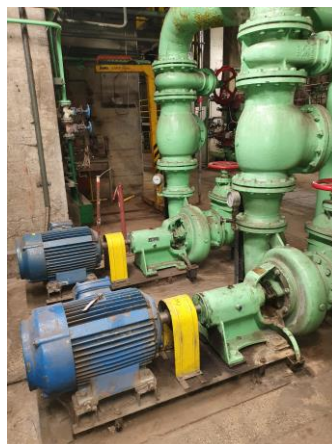
Slika 11: ČPT – črpalka za povišanje tlaka (Lastni vir)
