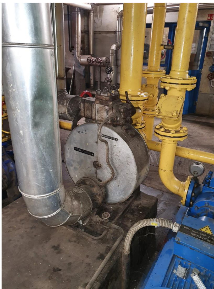
Slika 9: Pomožna oljna črpalka gnana s svežo paro 90 bar (Lastni vir)
