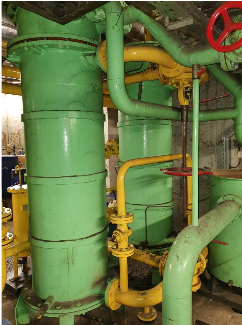
Slika 6: Hladilniki olja (Lastni vir)
