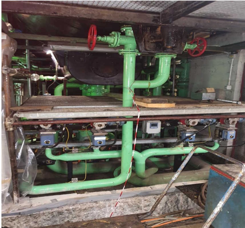
Slika 13: Grobi filter Amiad SAF za filtriranje hladilne vode (Lastni vir)
