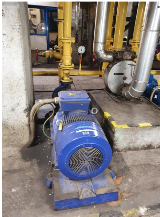
Slika 7: Pomožna oljna črpalka 55 kW (Lastni vir)
