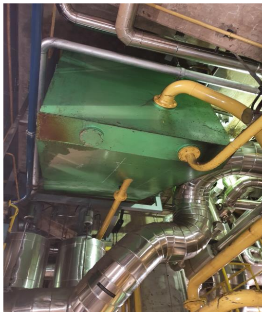
Slika 5: Rezervoar olja (Lastni vir)
