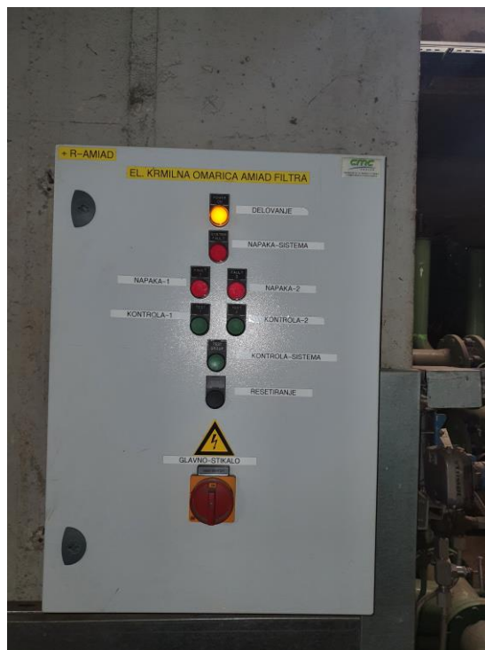
Slika 16: Krmilna omarica filtra Amiad (Lastni vir)
