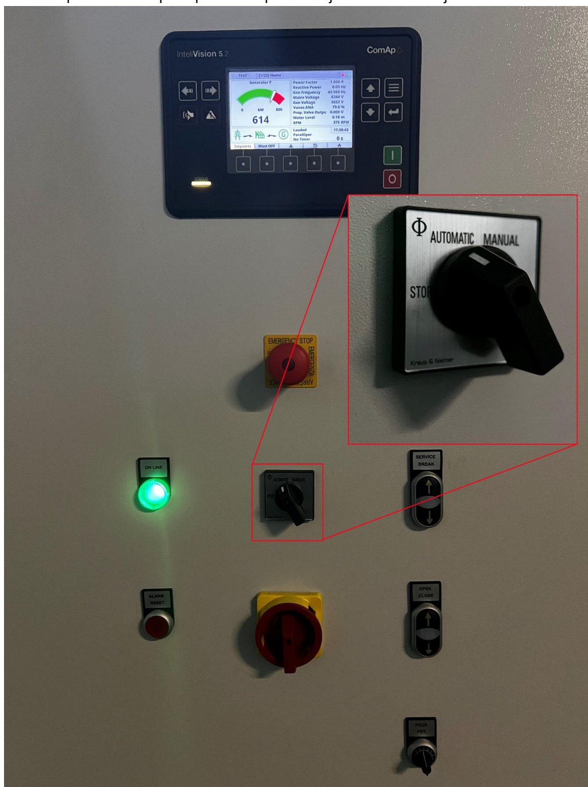
Slika 23: Glavno stikalo na regulacijski omari agregata (Lastni vir)
