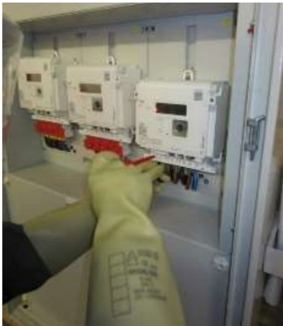
Slika 14: Montaža števca pod napetostjo (Vir: Lovrenčić in Lovrenčić, 2026)
