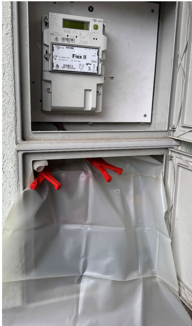
Slika 12: Izobraževanje monterja za menjavo števca pod napetostjo (Vir: Lovrenčić in Lovrenčić, 2026)
