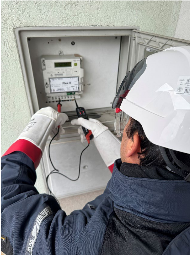
Slika 11: Izobraževanje monterja za menjavo števca pod napetostjo (Vir: Lovrenčić in Lovrenčić, 2026)
