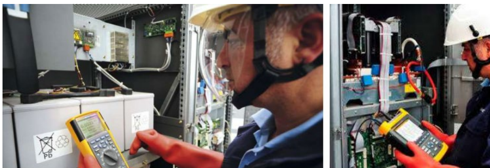
Slika 15: Uporaba OVO za delo pod napetostjo za izvajanje meritev (Vir: Lovrenčić in Lovrenčić, 2026)
