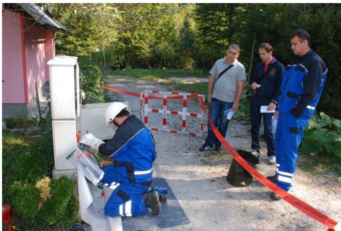
Slika 8: Delavec pri izvedbi DPN (Vir: Elektro Ljubljana, 2011a)
