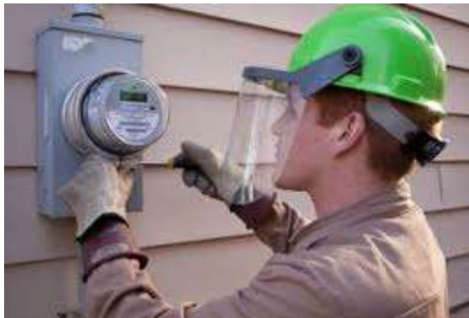
Slika 19: Menjava severnoameriškega tipa števca (Vir: Lovrenčić, 2020c)
