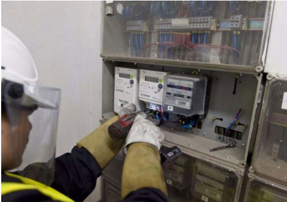
Slika 6: Izvajanje menjave števca z metodo DPN (Vir: Lovrenčič V., 2020d)
