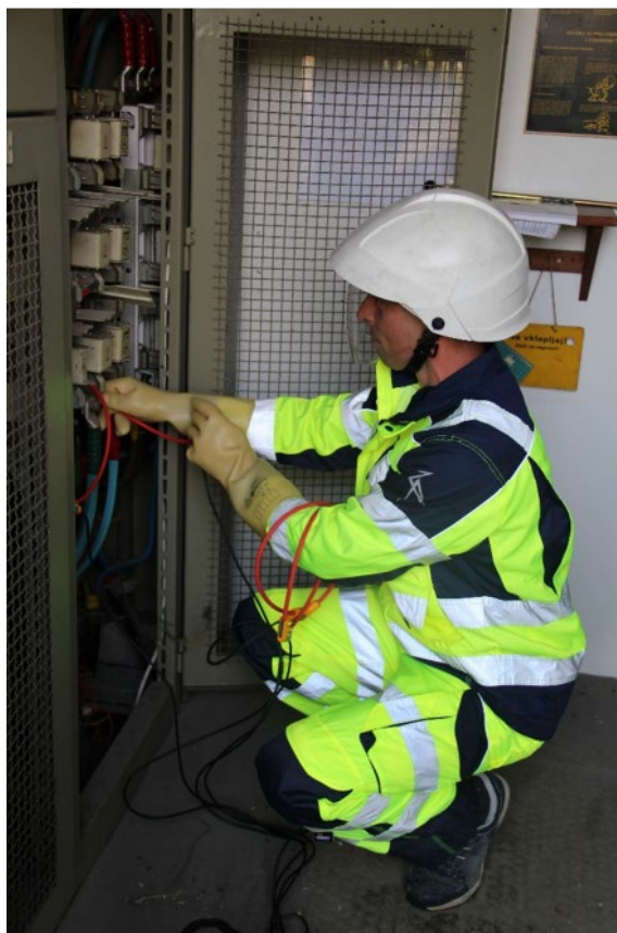
Slika 10: Izvajanje meritev v TP (Vir: Lovrenčič, 2020d)
