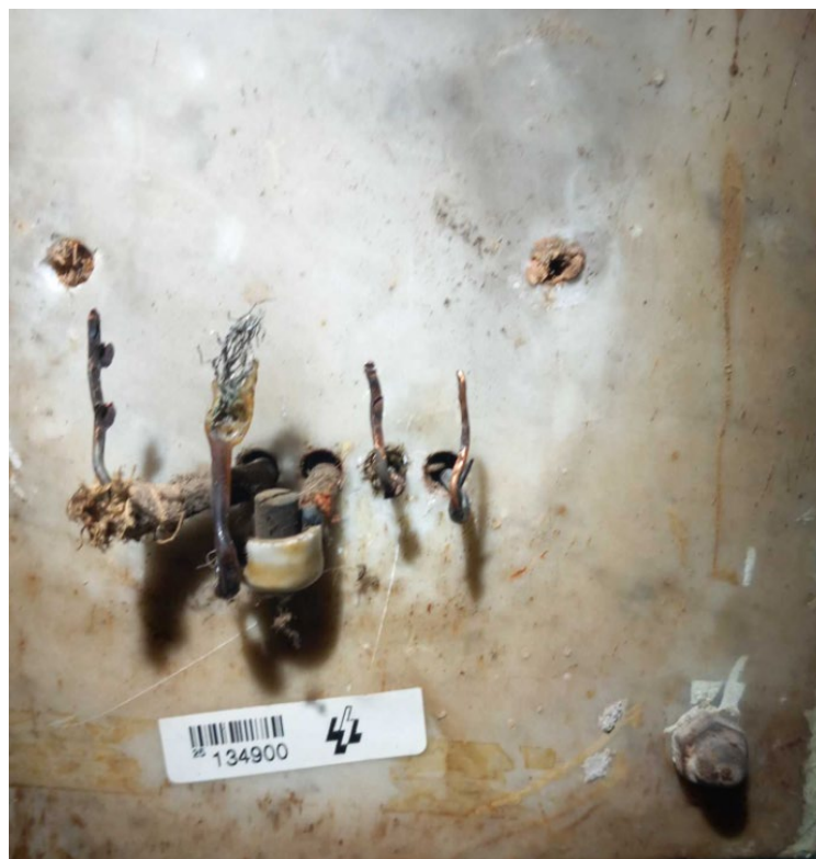
Slika 7: Primer neprimernega priključnega merilnega mesta (Lastni vir)
