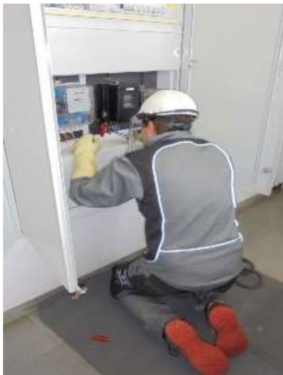
Slika 16: Nameščanje merilnih garnitur (Vir: Lovrenčić, 2020d)
