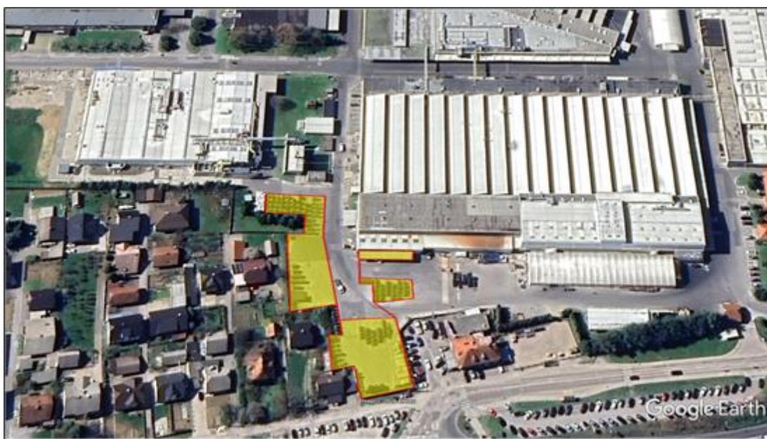
Slika 8: Skladišče 6000 v poslovni coni Sava Labore (rumeno področje) (Vir: Google Earth, 2023)
