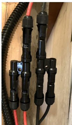
Slika 11: Y kos MC4 solarnega konektorja – združevanje dveh nizov (Lastni vir)
