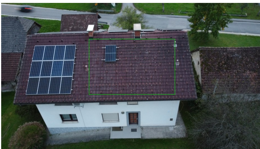
Slika 6: Prostor za nadgradnjo sončne elektrarne na stanovanjski hiši (Lastni vir)
