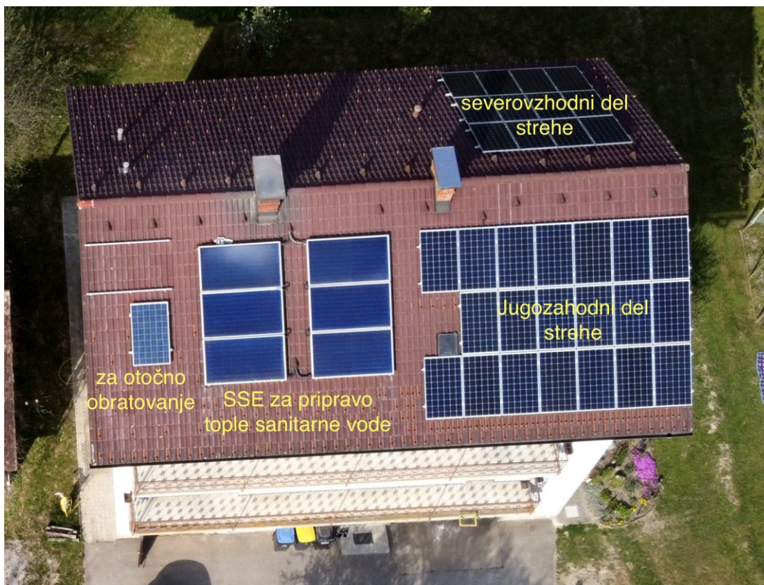
Slika 2: Domača hiša s sončno elektrarno po 1. nadgradnji (Lastni vir)
