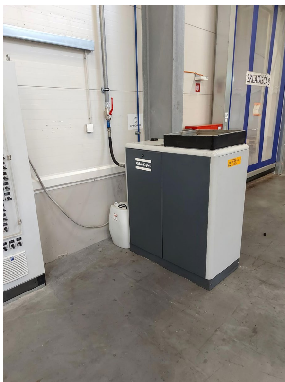
Slika 8: Začasni priklop starega kompresorja (Lastni vir)
