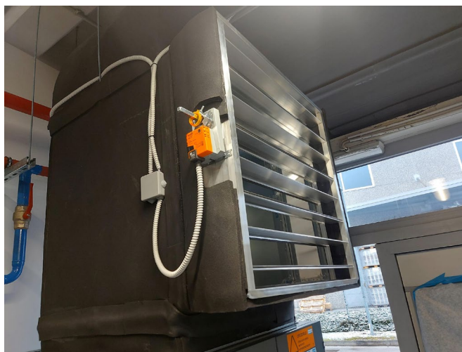
Slika 10: Žaluzije za nastavitev temperature v postaji (Lastni vir)
