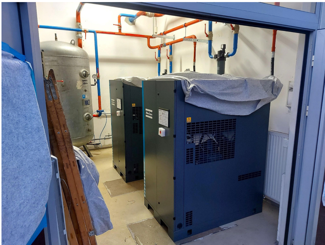
Slika 9: Priklop novih kompresorjev (Lastni vir)
