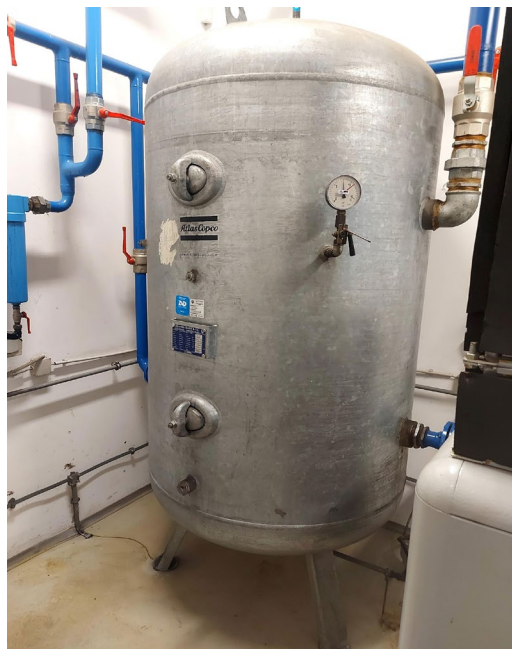
Slika 4: Tlačna posoda (Lastni vir)
