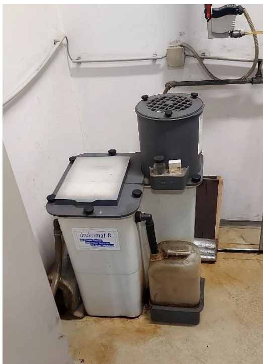
Slika 5: Separator voda-olje (Lastni vir)
