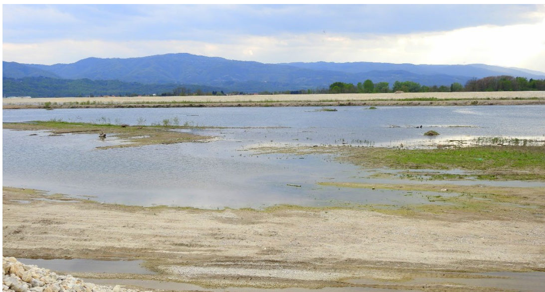
Slika 20: Zamuljevanje, HE Brežice (Vir: Klenovšek, 2022)
