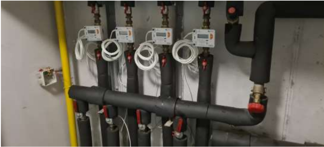
Slika 8: Vgrajeni merilniki toplotne energije za različna odjemna mesta (Vir: Lastni vir)
