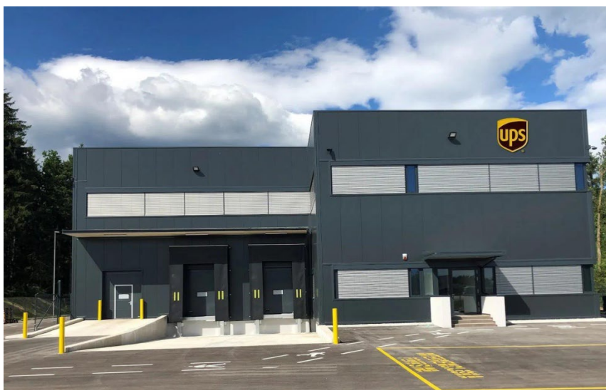
Slika 4: Stavba UPS na Brniku (Vir: Mojastoritev portal, 2025)
