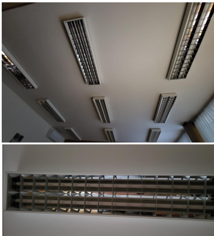
Slika 6: Primer svetilke pred prenovo s fluorescentnimi sijalkami (Lastni vir)
