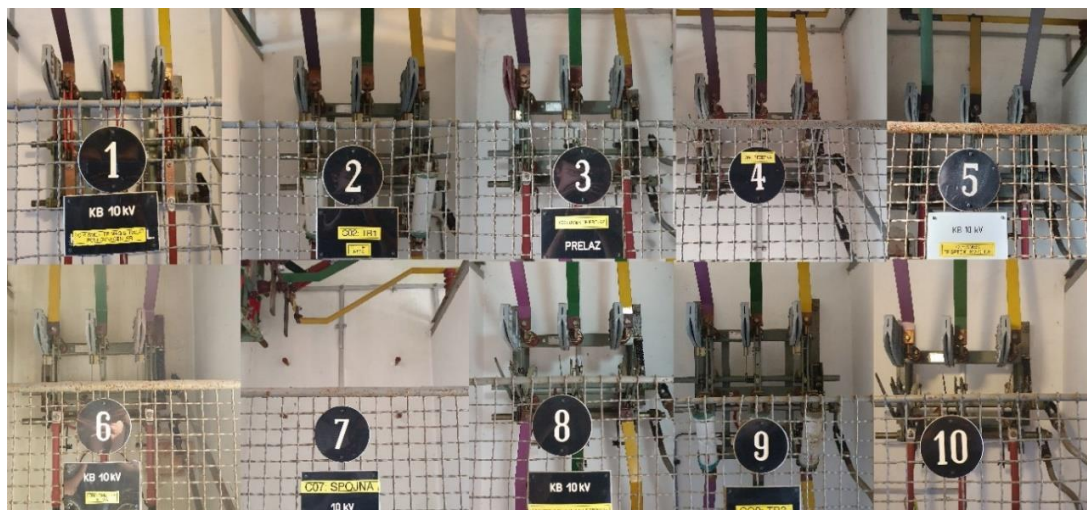
Slika 5: SN zračne celice z vgrajenimi odklopnimi ločilniki (Lastni vir)
