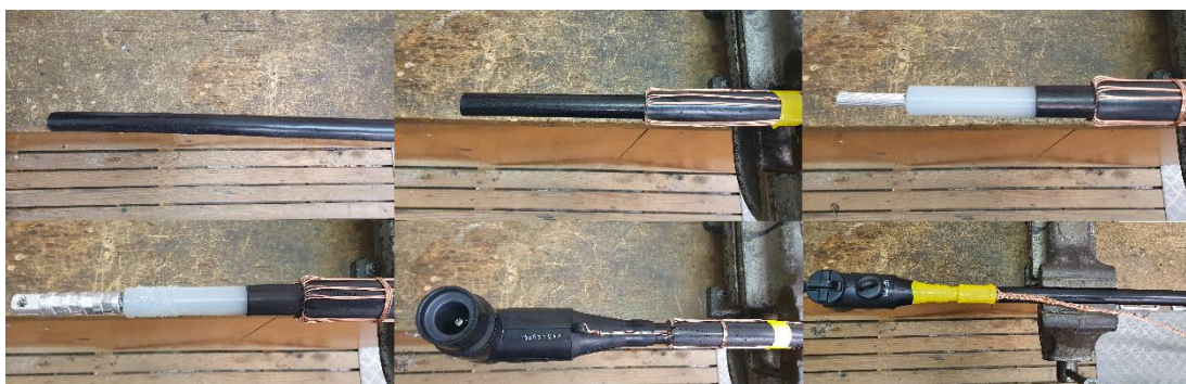
Slika 6: Postopek izdelave kablskega končnika za TR (Lastni vir)
