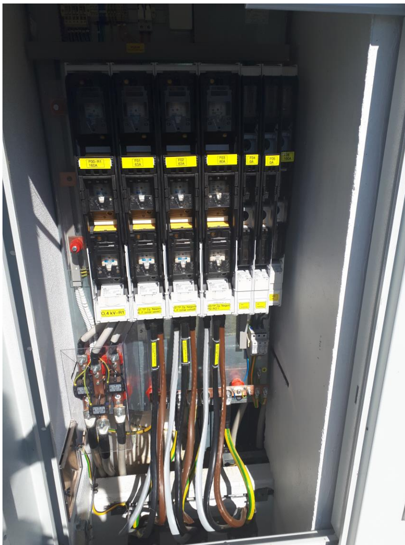
Slika 6: Niskonapetostni razdelilec (Vir: lasten)
