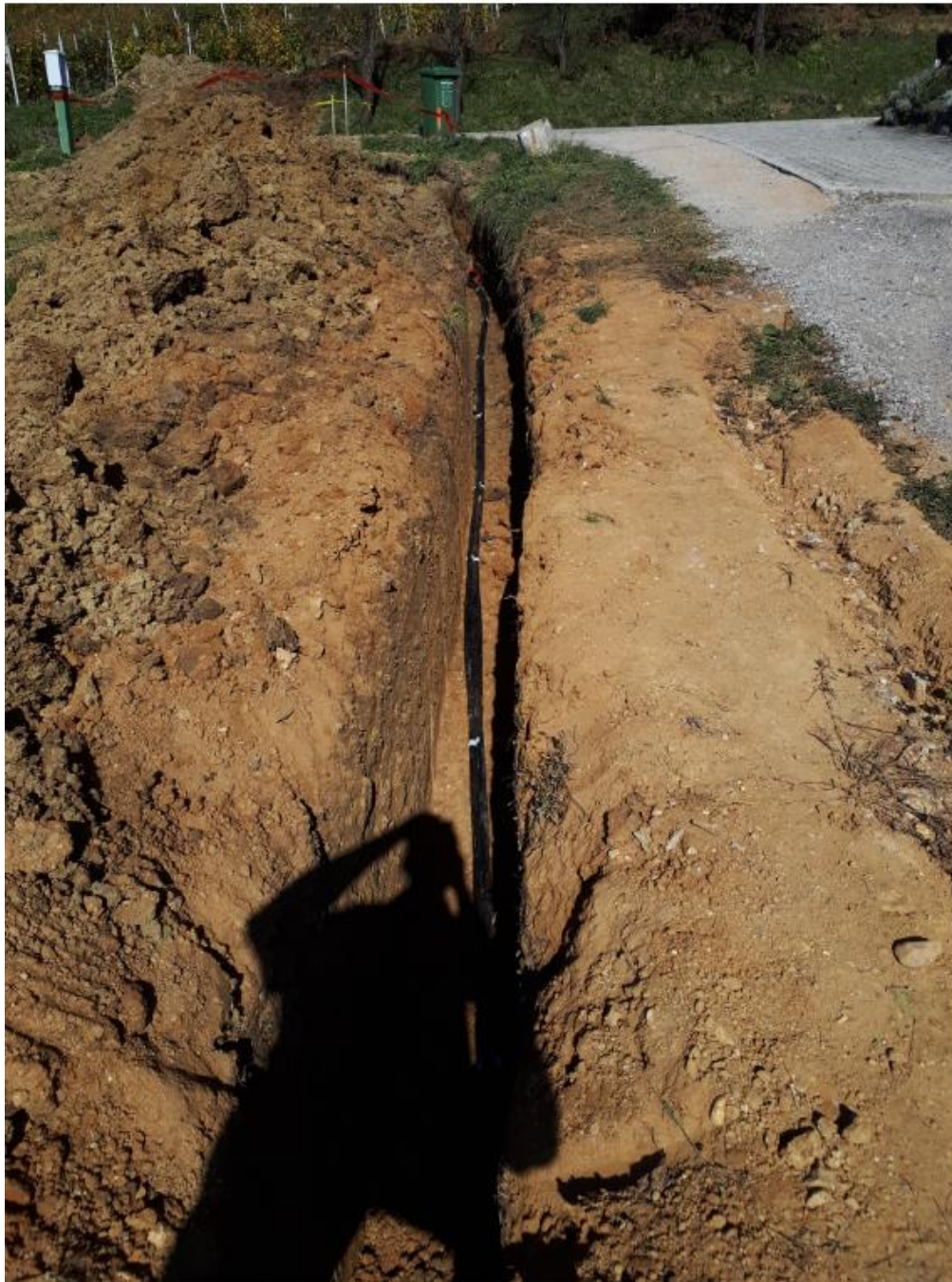
Slika 8: Polaganje kablovoda (Vir: lasten)
