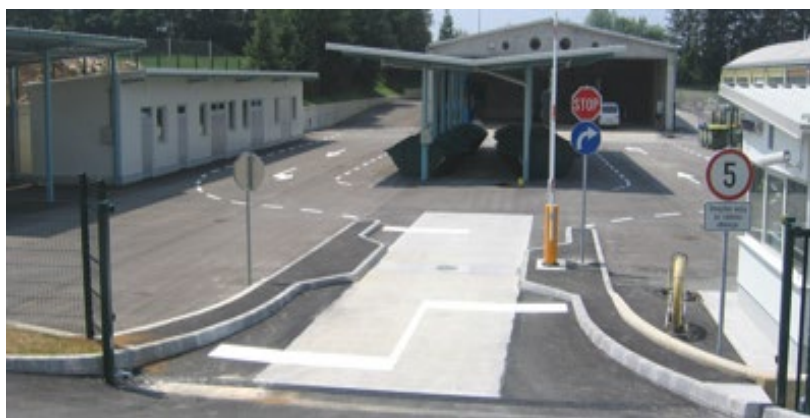
Slika 4: Zbirno reciklažno center Novo mesto (Vir: Komunala Novo mesto, 2023)
