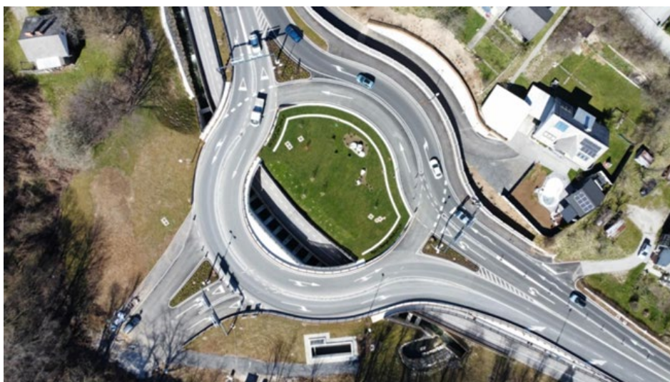
Slika 18: Krožišče za bohinjsko obvoznico (Vir: Grega Brenkuš, 2025)
