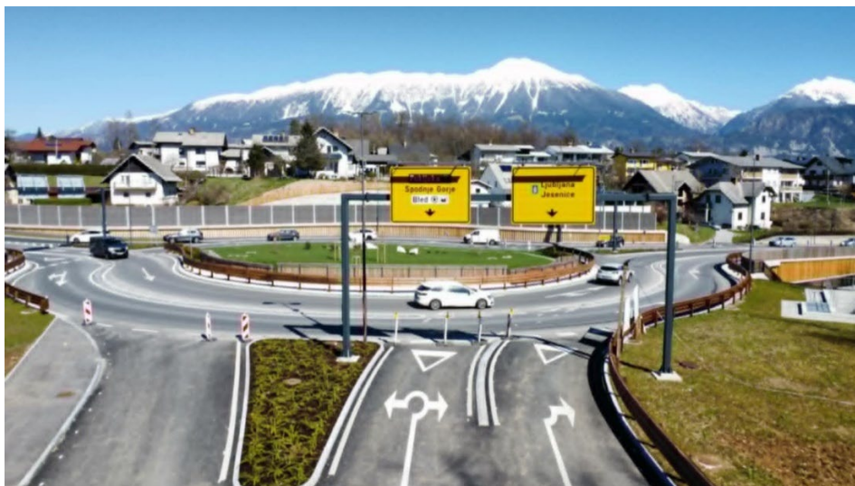
Slika 26: Krožišče za bohinjsko obvoznico (Vir: Grega Brenkuš, 2025)
