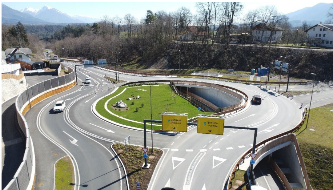
Slika 1: Krožišče za bohinjsko obvoznico (Vir: Grega Brenkuš, 2025)
