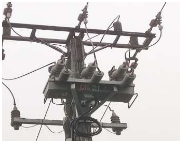
Slika 1: Kompaktni vakuumski odklopnik U27 za zunanjo montažo (Lastni vir)
