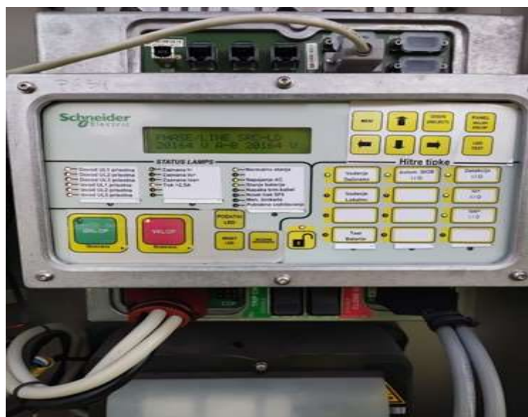
Slika 5: Krmilna plošča ADVC3 BS PG 34 (Lastni vir)
