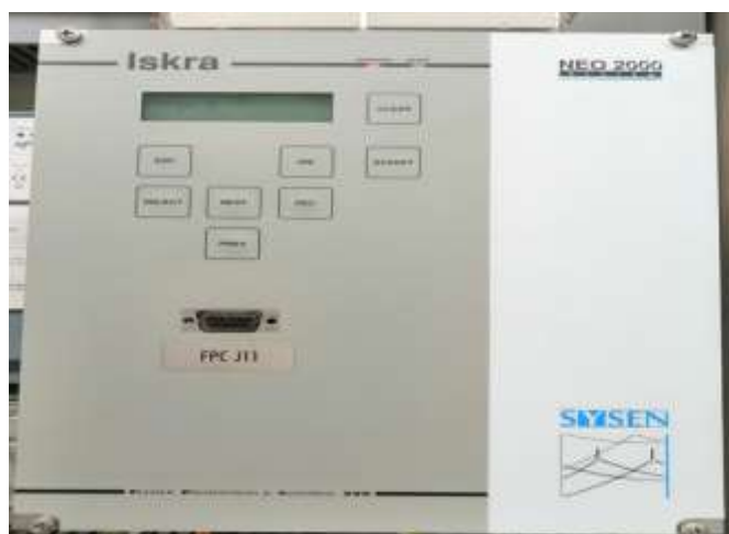
Slika 12: Zaščitni numerični rele (IED) Iskra FPC 501 (Lastni vir)
