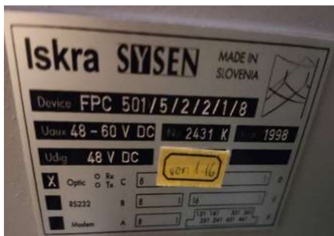
Slika 13: Zaščitni numerični rele (IED) Iskra FPC 501 (Lastni vir)
