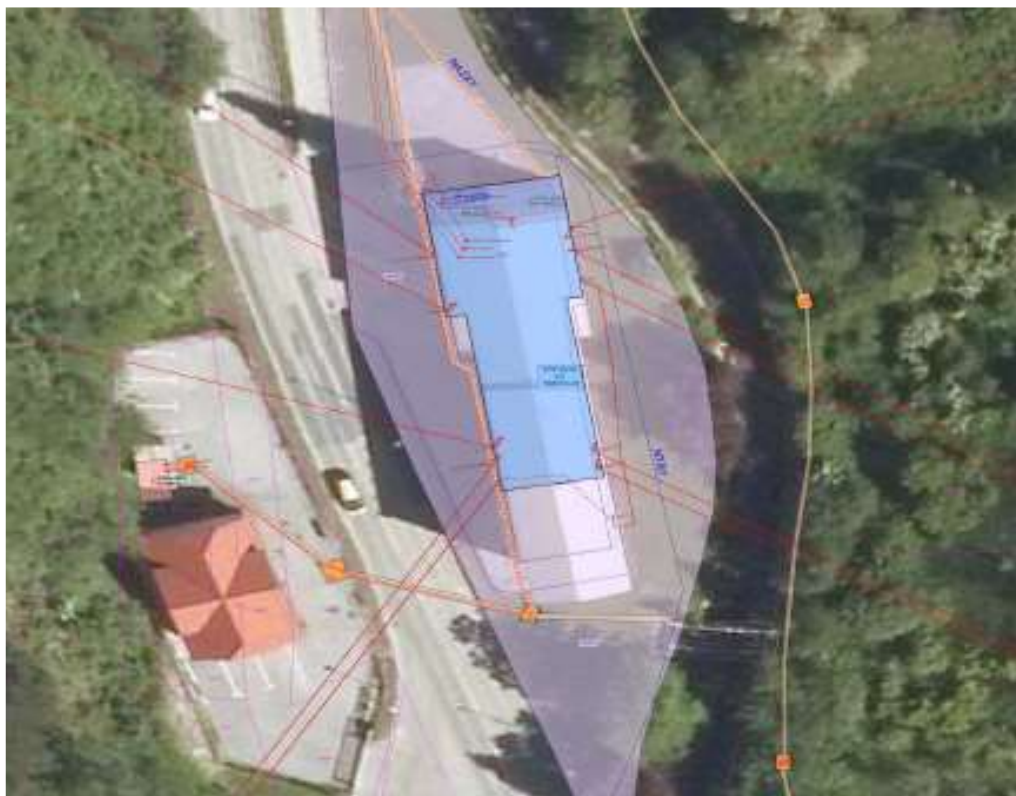
Slika 1: RTP 35/10 kV Trbovlje (Elektro Ljubljana, 2022)
