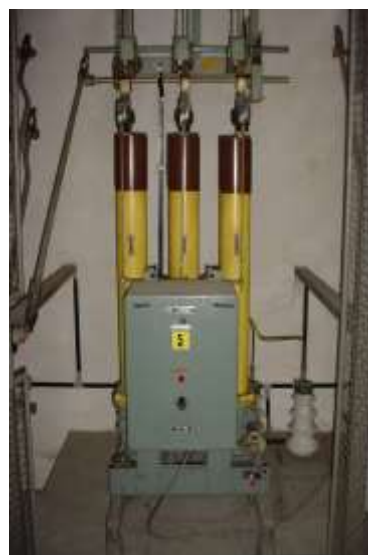
Slika 27: Odklopnik tipa HG (Lastni vir)
