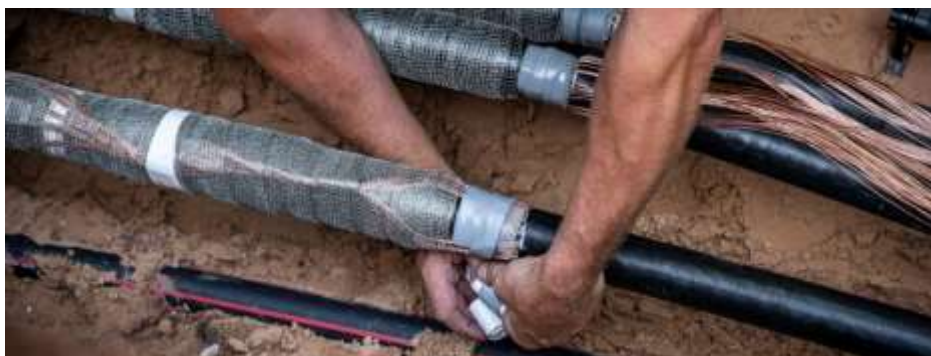
Slika 12: Izdelava kabelskih spojk (Lastni vir)
