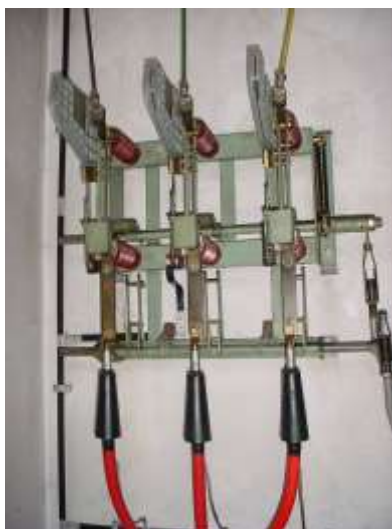
Slika 26: Odklopni ločilnik OLN (Lastni vir)
