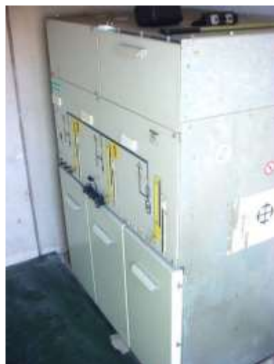
Slika 25: Odklopni ločilnik SF6 (SIEMENS) (Lastni vir)
