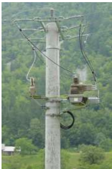
Slika 28: Odklopnik tipa NULEC na drogu (Lastni vir)
