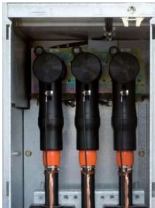
Slika 18: Kabljski končniki v celici (Lastni vir)
