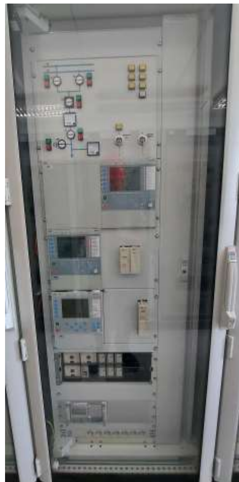
Slika 17: Omara vodenja in zaščit (Lastni vir)
