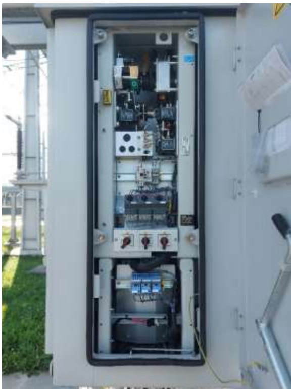
Slika 19: Omara odklopnika (Lastni vir)
