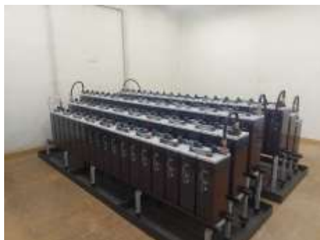
Slika 11: Baterija A RTP Divača (Lastni vir)
