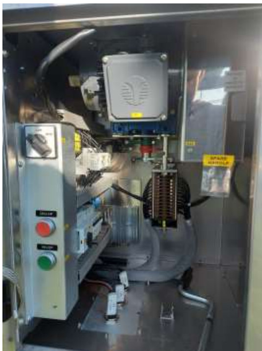
Slika 18: Omara pogona ločilnika (Lastni vir)
