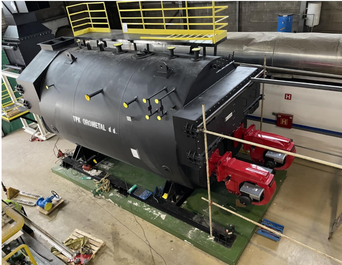
Slika 14: Slika kotla med montažo (Lastni vir)
