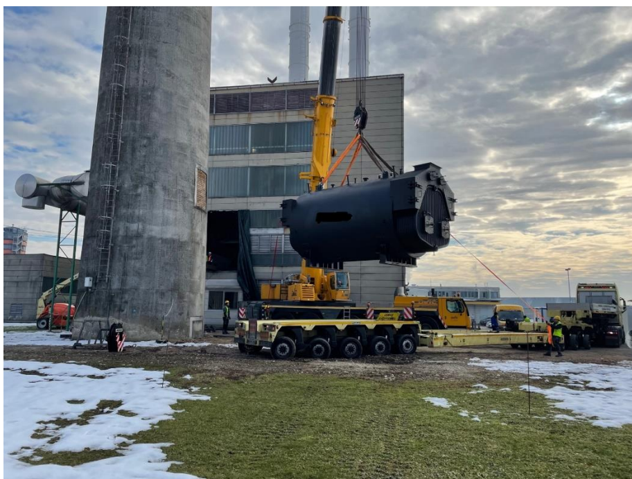
Slika 13: Slika dvigovanja kotla in pripravljene odprtine v stavbo (Lastni vir)
