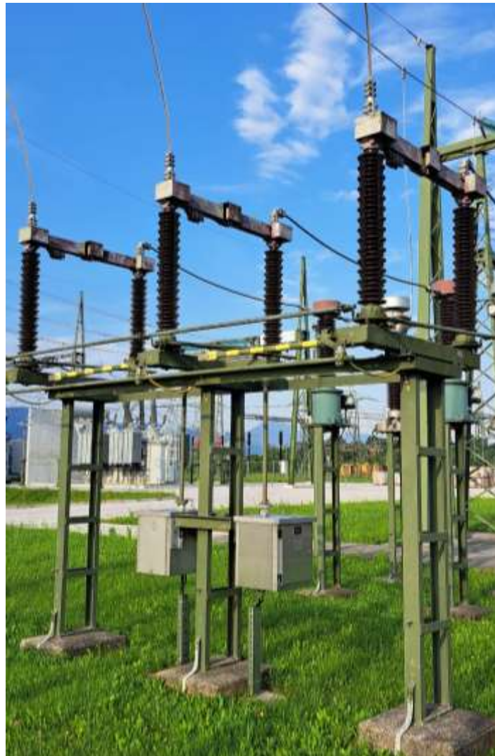
Slika 12: Daljnovidni ločilnik (Lastni vir)
