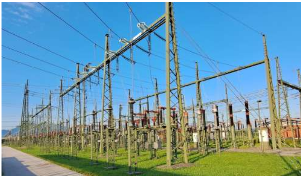
Slika 20: 110 Kv prostozračno stikališče (Lastni vir, 2023)
