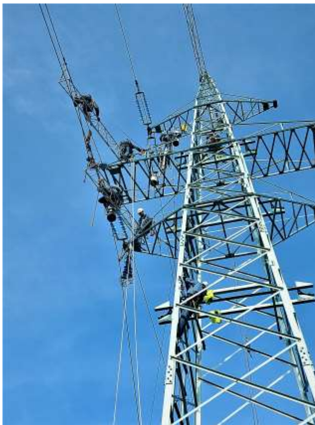
Slika 21: Elektromontažna dela na SM 15A (Lastni vir)
