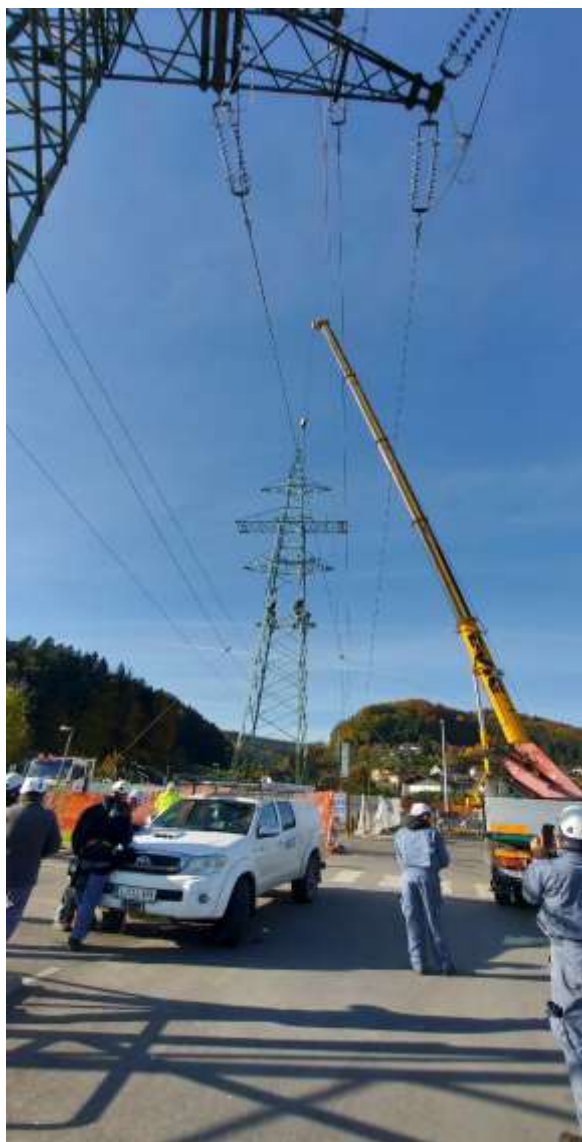
Slika 22: Postavitev 3. segmenta SM 15A s pomočjo dvigala (Lastni vir)
