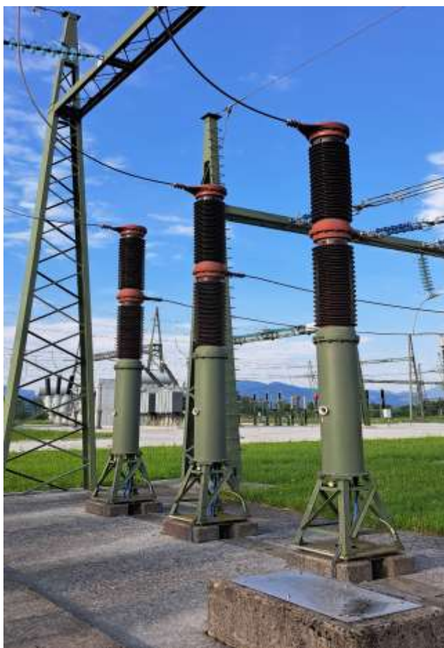
Slika 11: Odklopnik (Lastni vir)
