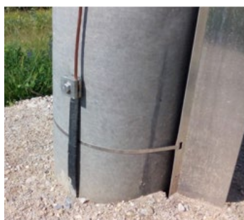
Slika 18: Pritrdilo za ozemljitveno vrv na BD (Vir: TS11, 2019)
