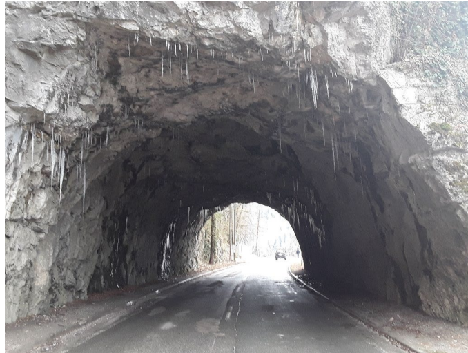
Slika 19: Čiščenje ledenih sveč – potrebno ročno orodje (Lastni vir)
