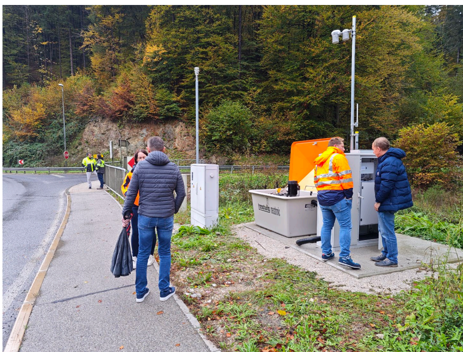
Slika 20: Priklop sistema za samodejno soljenje na cesti G1-4, odsek 1262 Črno–Arja vas (Lastni vir)
