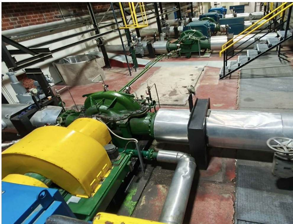
Slika 5: Črpalni agregati druge stopnje vročevodnega črpališča (Lastni vir)
