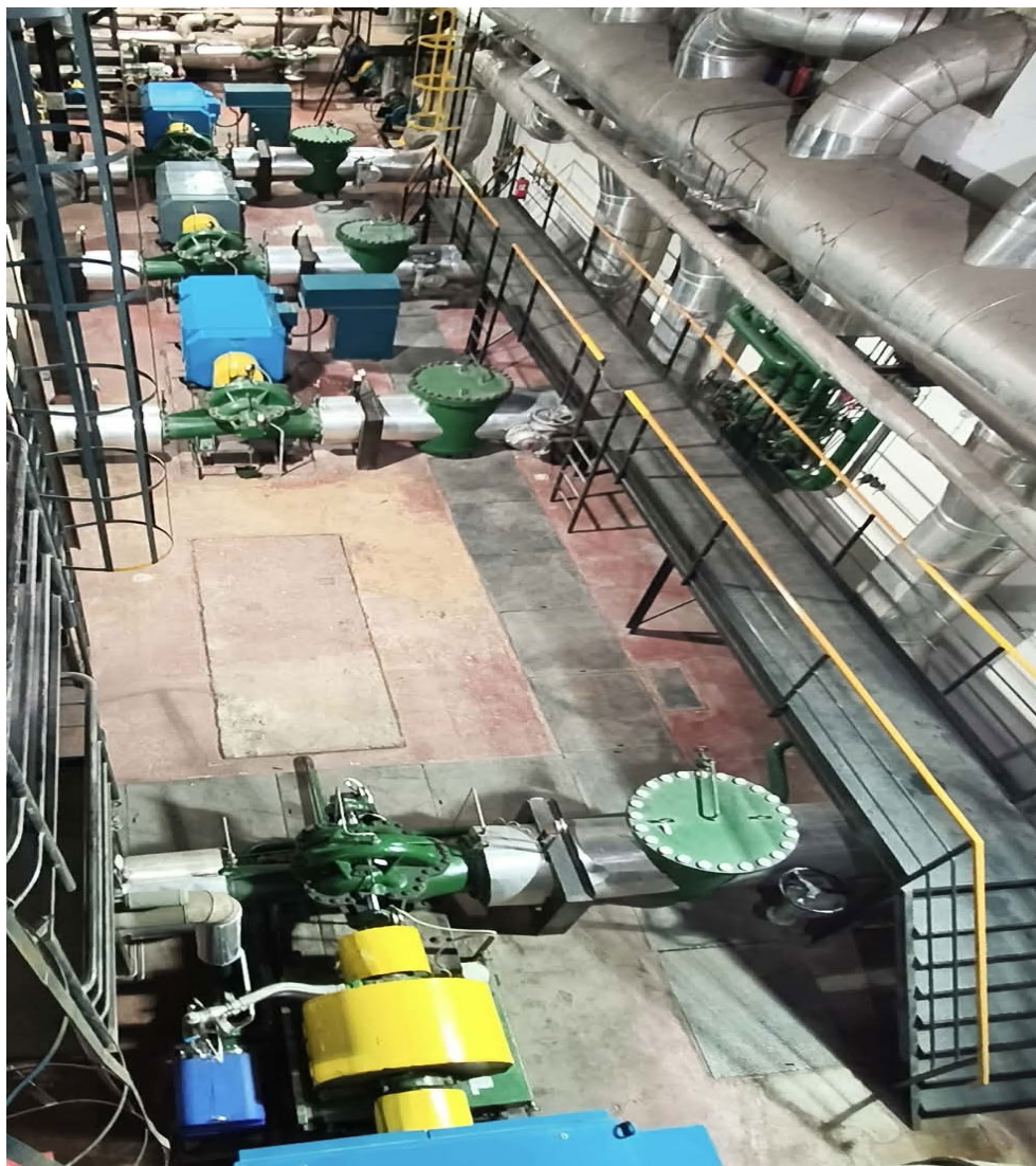
Slika 4: Črpalni agregati prve stopnje vročevodnega črpališča (Lastni vir)
