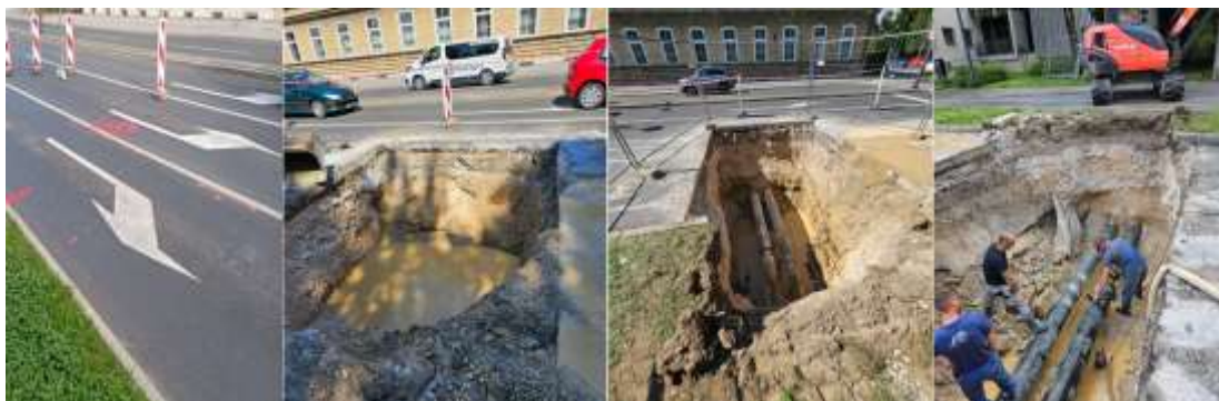
Slika 19: Potek gradbenih del in zamenjava poškodovanega dela cevi (Lastni vir)
