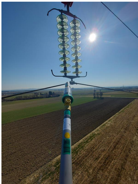
Slika 5: Preverjanje breznapetostnega stanja z indikatorjem prisotnosti napetosti (Lastni vir)
