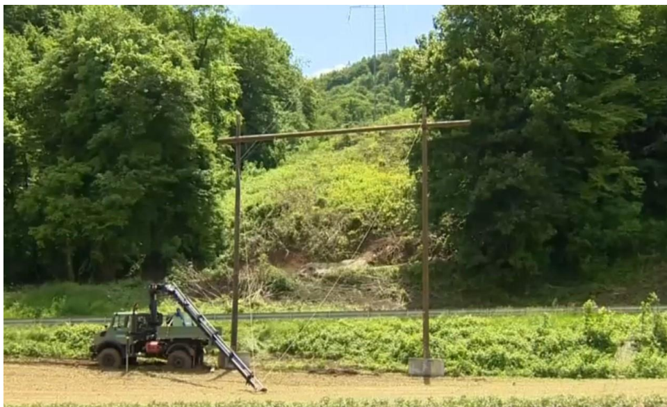
Slika 25: Križanje DV z magistralno cesto Sevnica–Krško in varovanje (Lastni vir)
