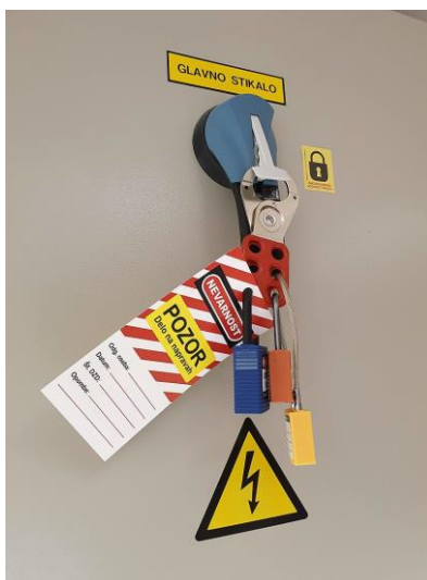
Slika 4: Primer zaklepanja stikala z uporabo škarij
