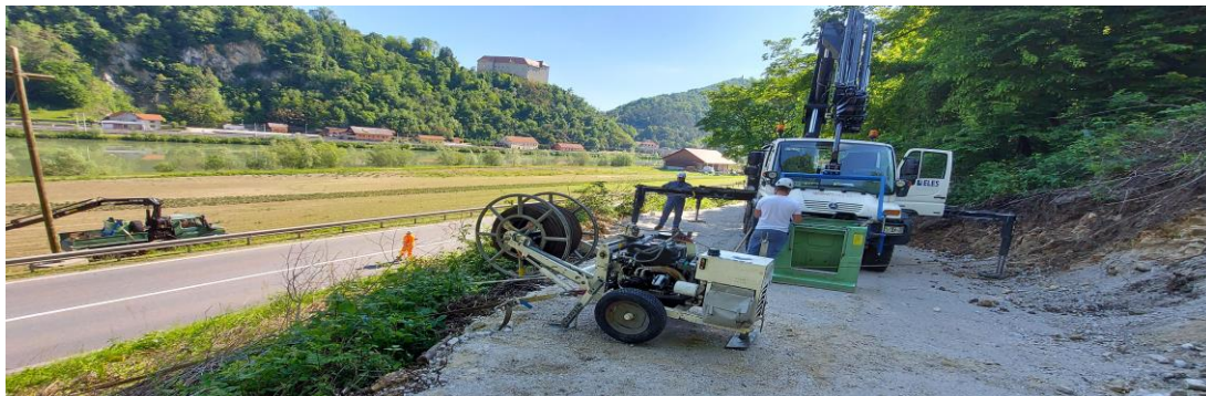
Slika 22: Urejeni delovni plato za potrebno delovno mehanizacijo (Lastni vir)
