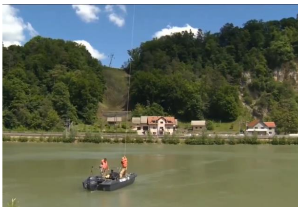
Slika 24: Križanje reke Save in prenos vodilne vrvi s čolnom (Lastni vir)
