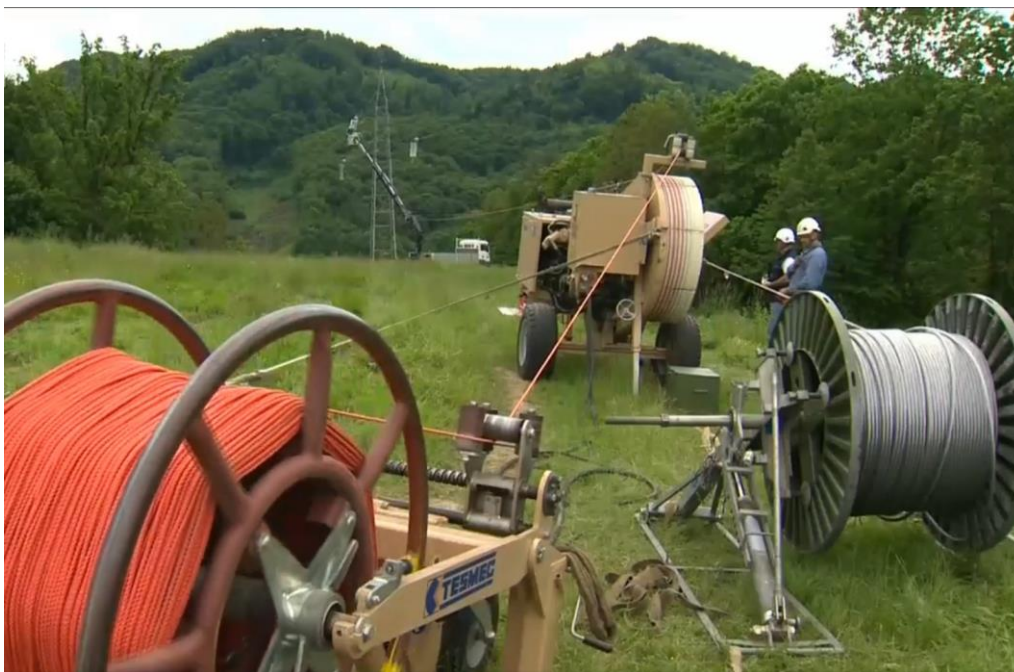
Slika 27: Mehанизacija za razvlek vodnika pri SM 8 (Lastni vir)
