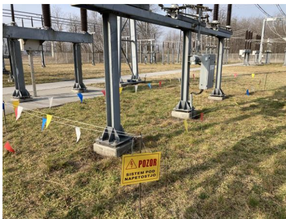
Slika 8: Opozorilna vrv z zastavicami za ograditev mesta dela (Lastni vir)
