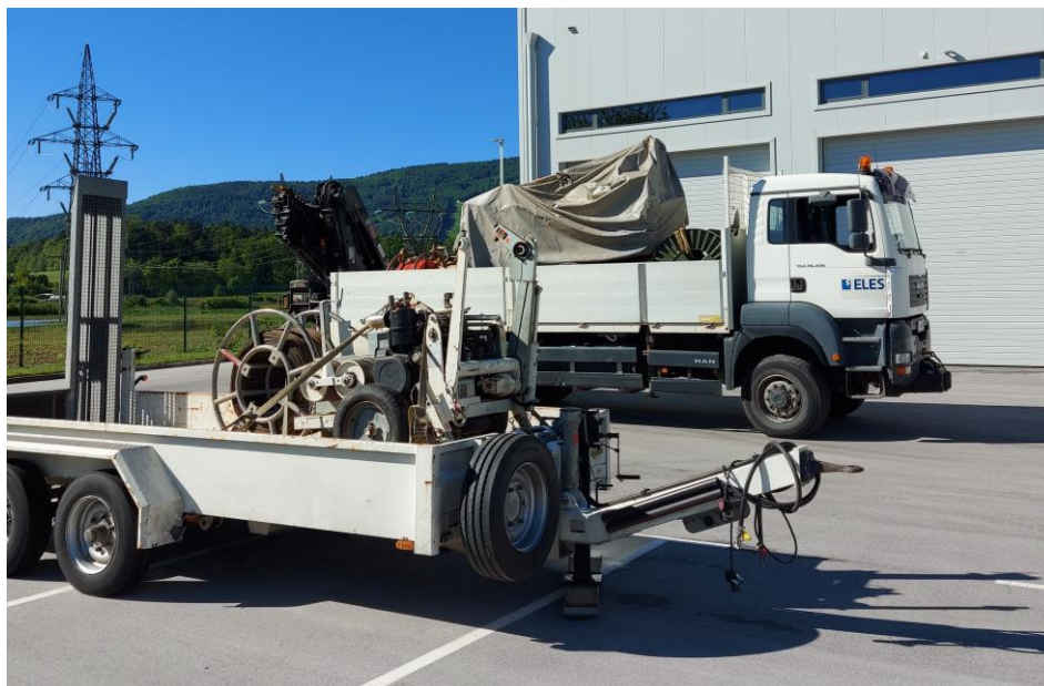
Slika 34: Transport mehanizacije in orodja za Sanacijo DV Brestanica–Hudo (Lastni vir)
