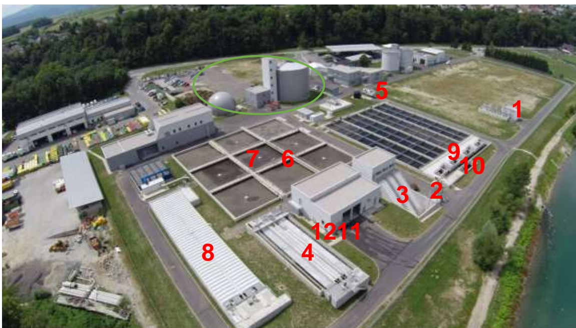
Slika 1: CČN Kranj (Komunala Kranj d.o.o., 2023)
