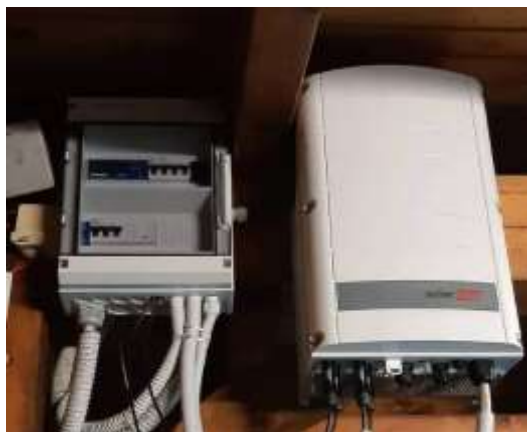
Slika 19: R – MSE Šoštarko in Razsmernik SolarEdge SE 15K (Lastni vir)
