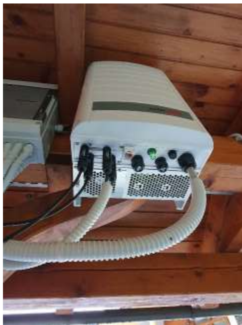
Slika 13: Razsmernik SolarEdge SE 15K (Lastni vir)
