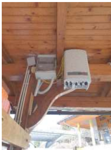
Slika 3: Prikaz AC/DC razsmernika ,oprema in vezave še v izdelavi (Lastni vir)
