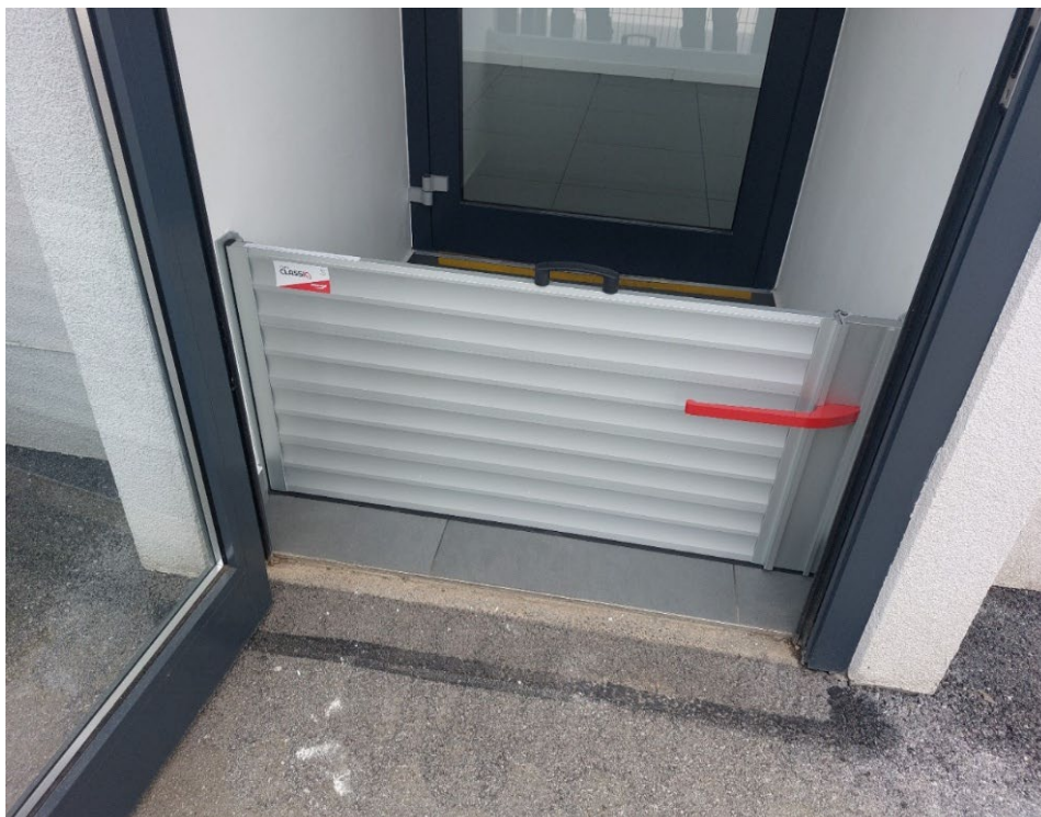
Slika 6: Nameščene protipoplavne zapornice kot preventivni ukrep (Vir: Zarja Elektronika d.o.o., 2023)
