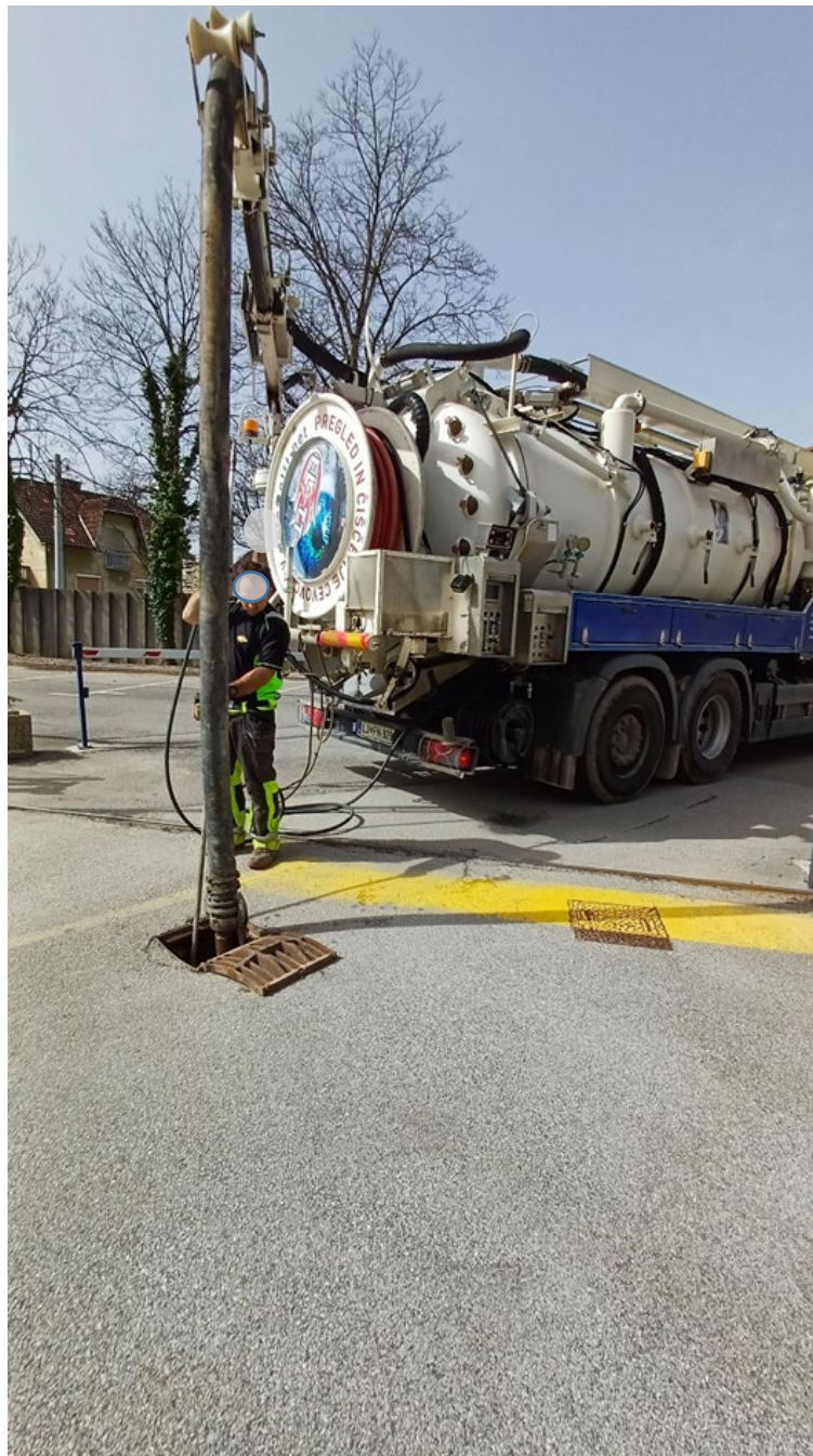
Slika 5: Čiščenje kanalizacijskega sistema po poplavah leta 2023 (Vir: Zarja Elektronika d.o.o., 2023)
