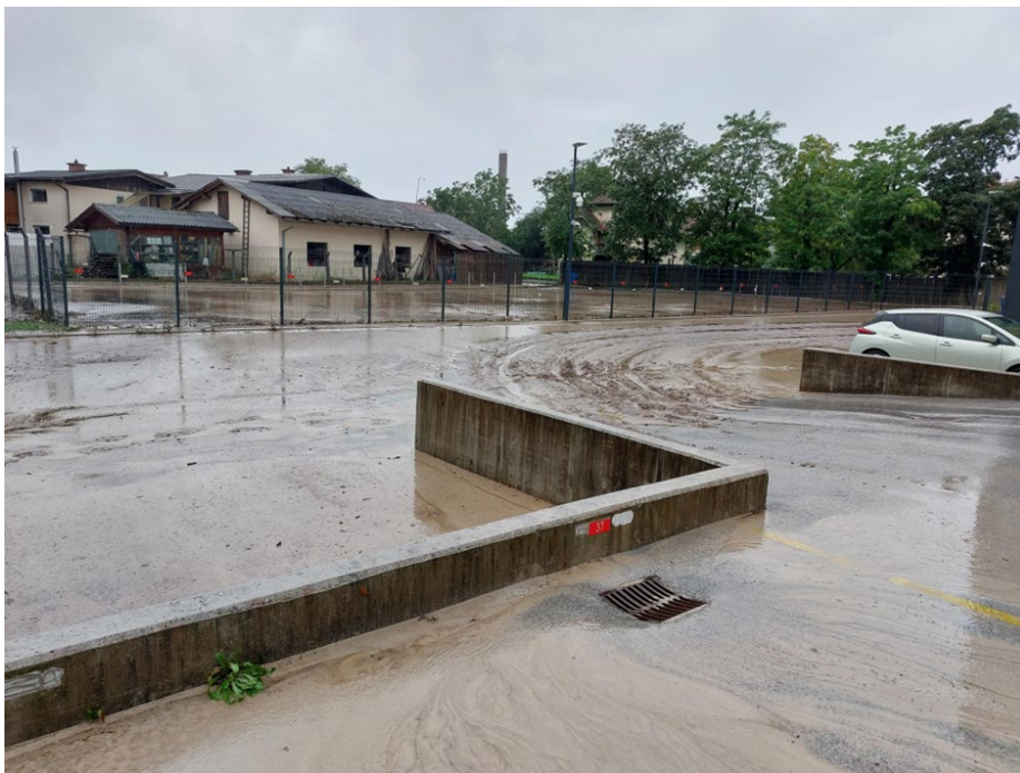
Slika 4: Poplavljeni parkirišče podjetja med poplavami leta 2023 (Vir: Zarja Elektronika d.o.o., 2023)
